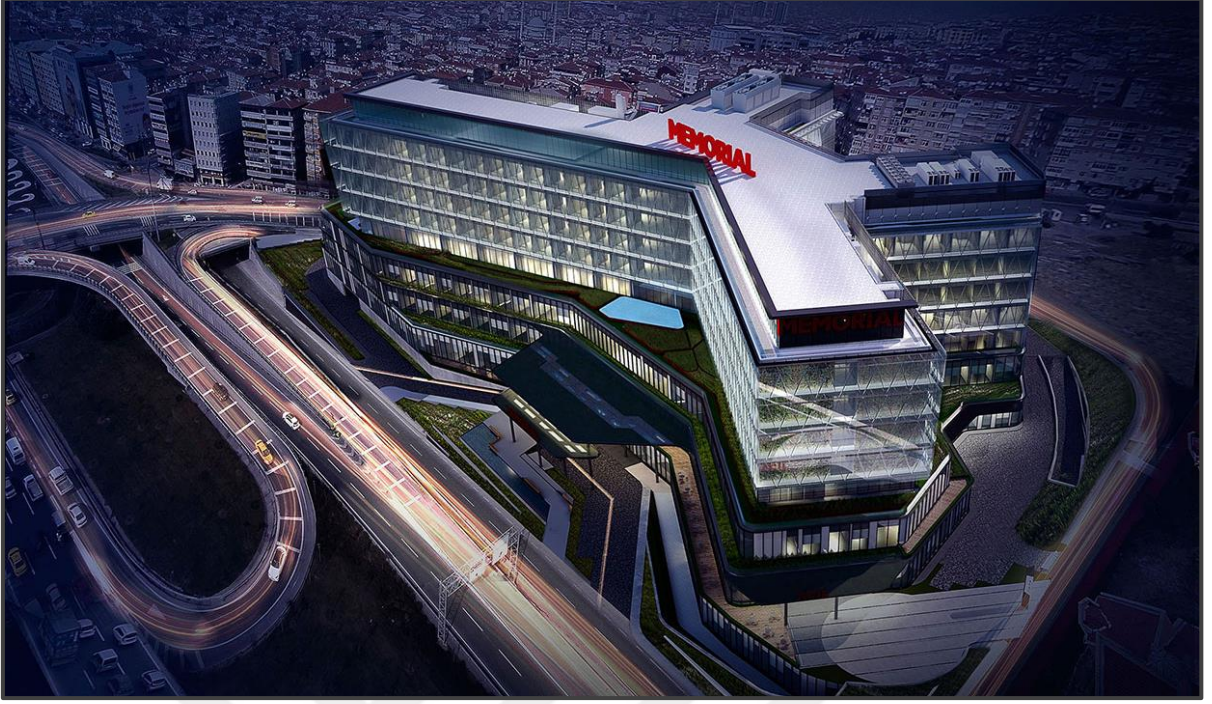
Şekil 3.1: Memorial Bahçelievler Hastanesi genel görünüm (Memorial, 2022).
