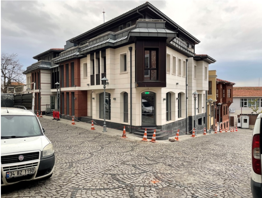
Fotoğraf 5: Süleymaniye Kentsel Yenileme Alanı Demirtaş Mahallesi 508 Adanın Günümüzdeki Durumu, Aralık 2022
