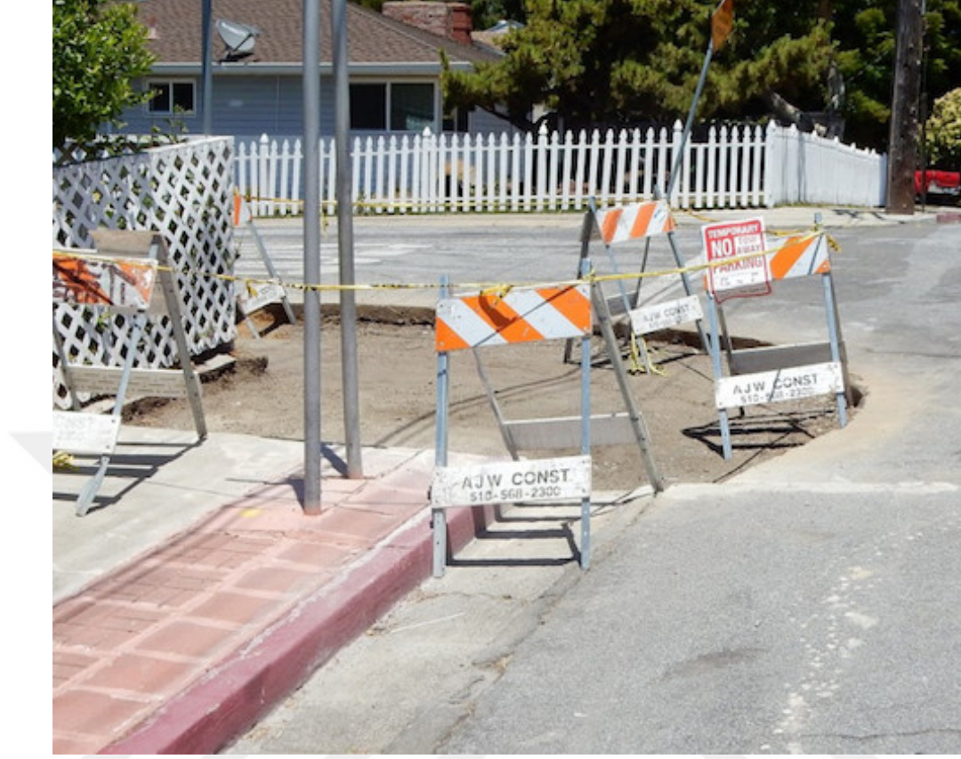
Şekil 2.7 Hayward fayında meydana gelen kripin kaldırım taşındaki kanıtının yok edilmesi [67]
