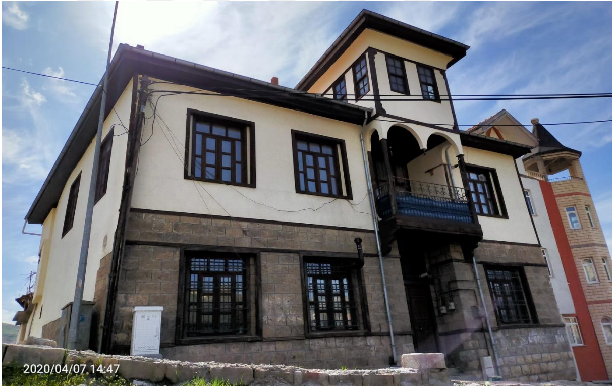
Fotoğraf 3.11 Çırakgiller Evinin ön dış cephesinden görünüm.
