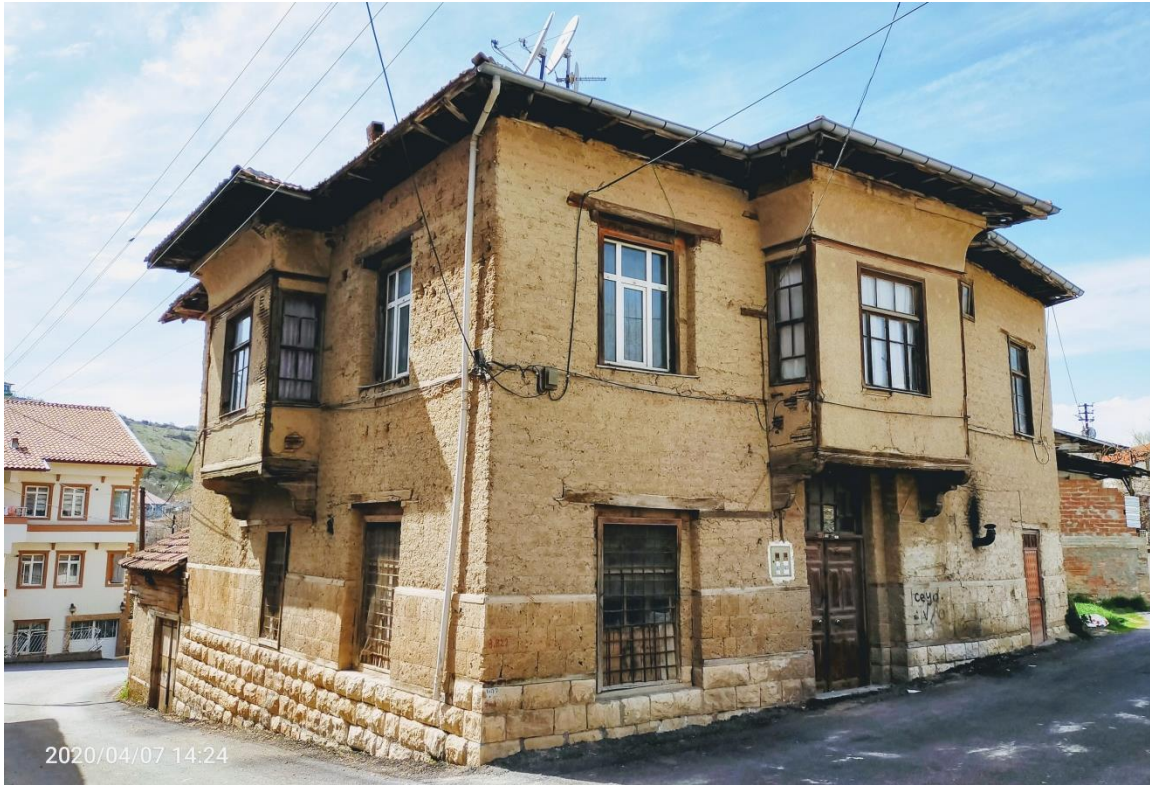
Fotoğraf 3.3 Geleneksel Yeşilyurt yerleşim ve meskenlerinde eğimli alanlar başarıyla iskâna açılmıştır. Eğimli arazi ev ve eklentilerinin konumlandırılmasına damgasını vurmuştur. İmamgillerin evi özgün yapı malzemeleriyle günümüze kadar gelmiş önemli meskenlerden biridir.
