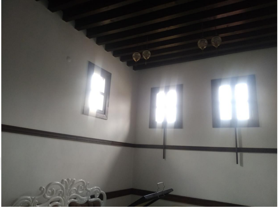
Fotoğraf 3.2 Yeşilyurt merkezindeki Hanifi Tanbay Evinin yatak odasının duvar-pencere ayrıntısı. Pencerelem zeminde yüksekten tavana yakın inşa edilmiştir. Mahremiyet düşüncesinin yapı estetiğine yansıtılmasının başarılı bir örneği.
