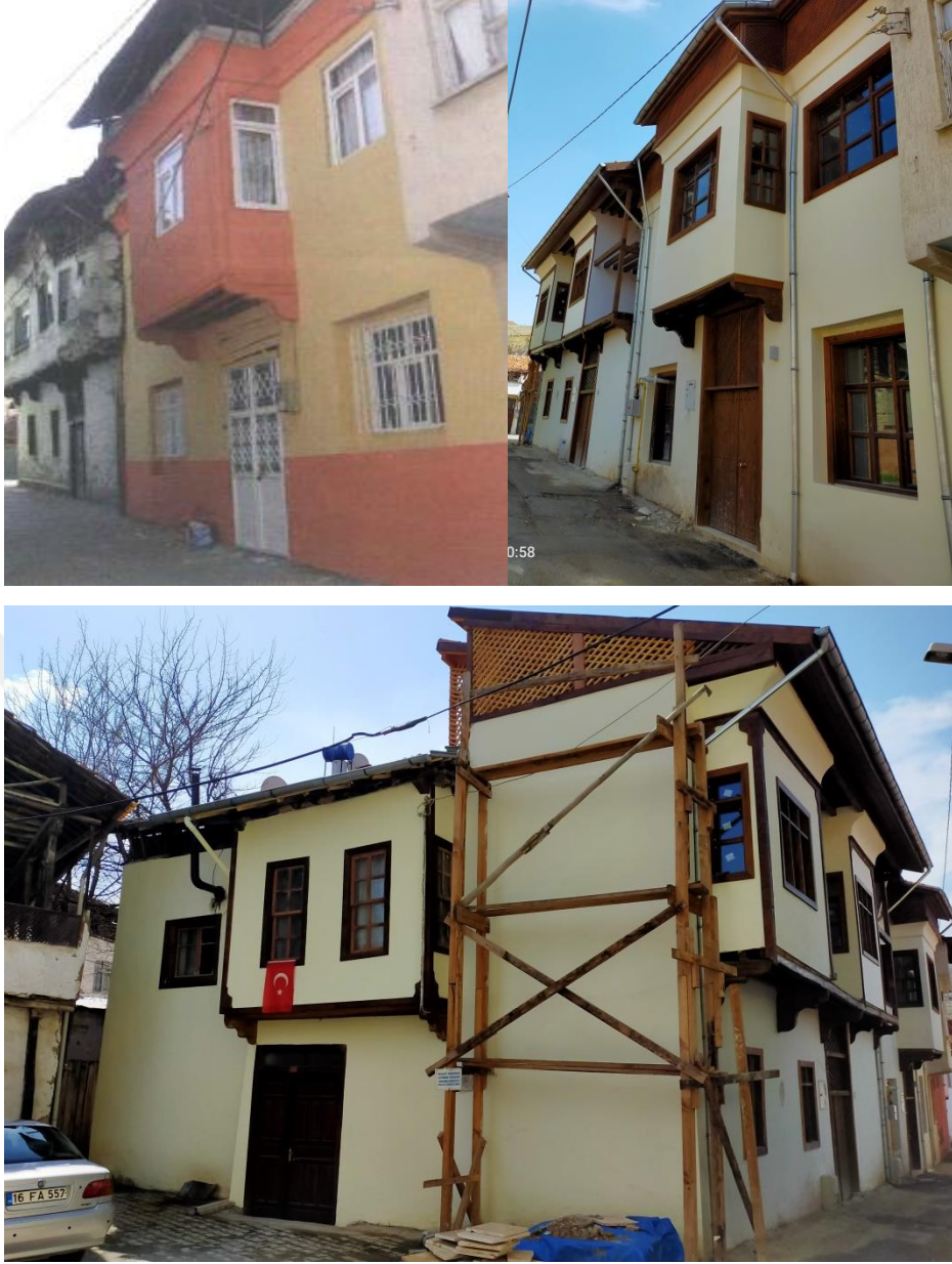
Fotoğraf 3.16 Yılmaz Çapan Evi, boyası badanası ve iki kere değiştirilen kapısı ile özgünlüğünü önemli ölçüde kaybetmiştir.
