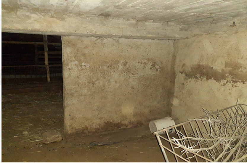
Şekil 4.5. Taşıyıcı sistem olarak betonarmenin kullanıldığı ağıl (Manavgat)
