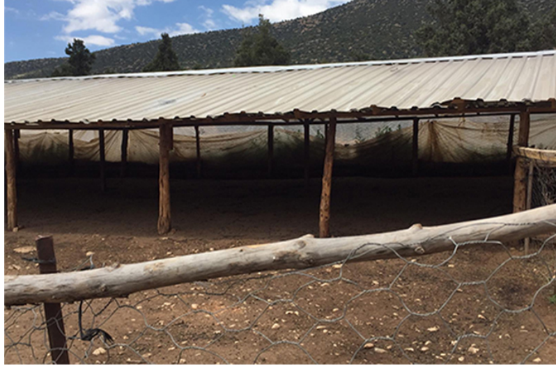
Şekil 4.6. Tek eğimli çatı sisteminin kullanıldığı ağıl (Gazipaşa)
