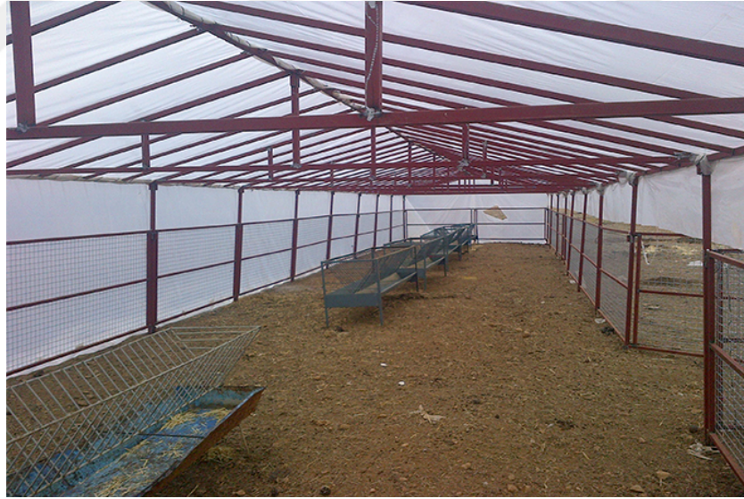
Şekil 4.3. Taşıyıcı sistem olarak profil demirinin kullanıldığı ağıl (Finike)
