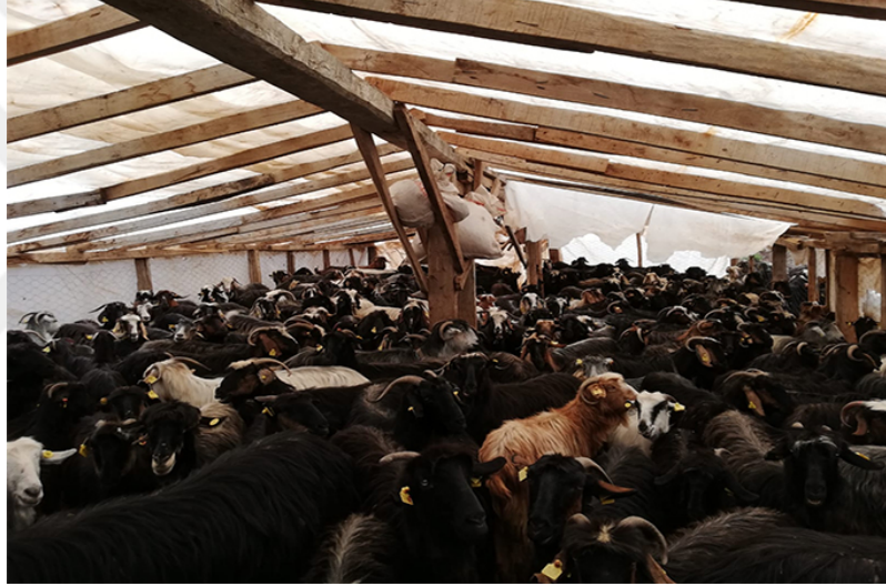
Şekil 4.7. Beşik çatı sisteminin kullanıldığı ağıl (Elmalı)
