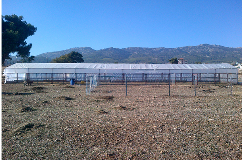
Şekil 4.9. Çatı örtü malzemesi olarak naylonun kullanıldığı ağıl (Demre)
