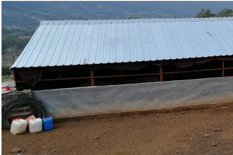
Şekil 4.11. Çatı örtü malzemesi olarak oluklu levhanın kullanıldığı ağıl (Konyaaltı)
