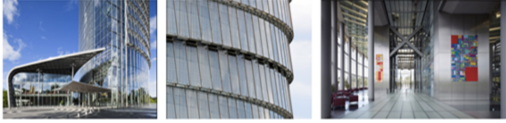
Şekil 2.53 Aerosil dolgulu cam cephe panelleri, Deutsche Post yapısı (Almanya) [161]
