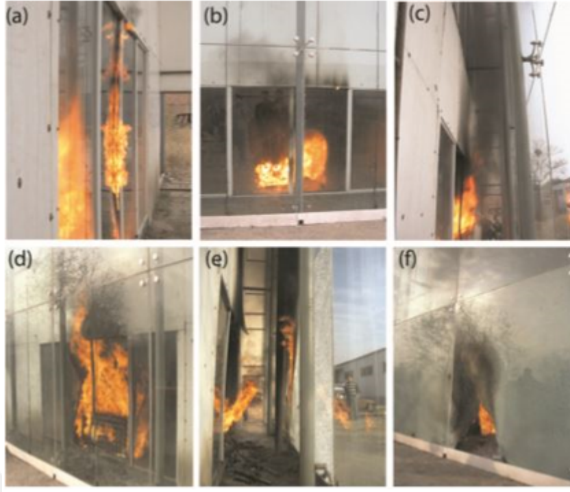
Şekil 2.21 Çift katmanlı cephe sistemi yangın testi a) yangının başladığı odadan itibaren iç yüzeyden geçmesi b) kırılan iç cam paneli c) duman ve gazların hava boşluğunda yayılması, d) dıştaki çift katlı cam panelin arasında bulunan jel yüzeyin yanması, e) dış katmandaki camın kırılması [71]
