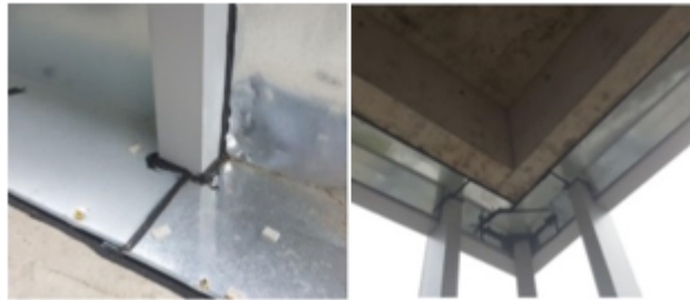
Şekil 2.24 Giydirme cephelerde yangın durdurucu uygulaması örneği [84]
