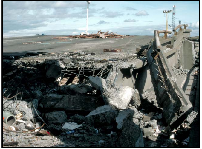
Şekil 1.2: Çöken Cypress Viyadüğü’nün gövdesinden görüntüler (Nakata ve diğ., 1999).
