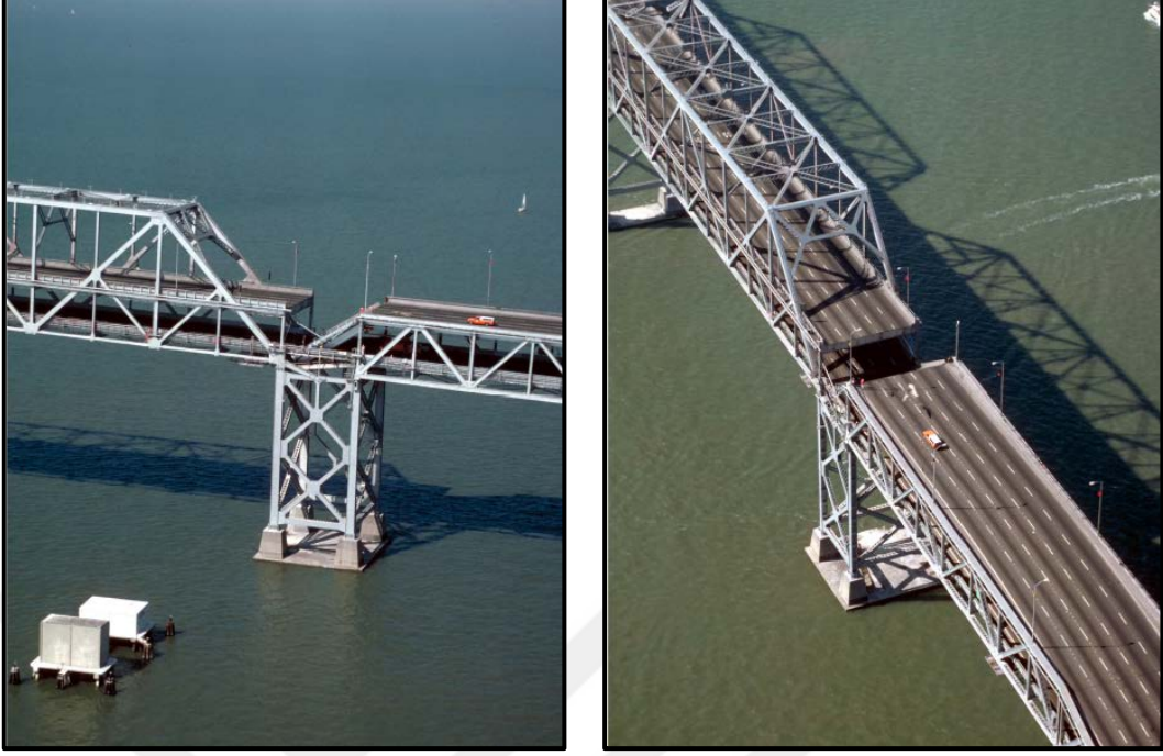
Şekil 1.1: Çöken San Francisco–Oakland Körfez Köprüsü’nün görüntüleri (Nakata ve diğ., 1999).
