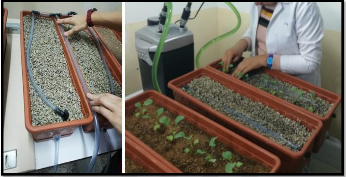
Şekil 3.4 Akuaponik sistemin kurulum aşaması
