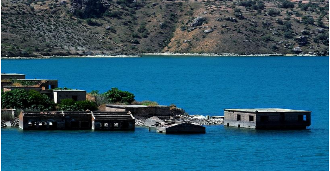
Şekil 20: Çekem Mahallesi Sular Altında Kaldıktan Sonra
