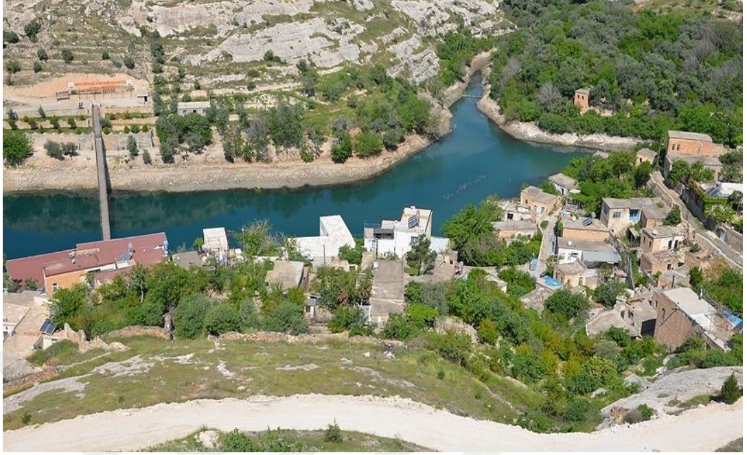
Şekil 40: Halfeti Kuş Bakışı Görünümü
