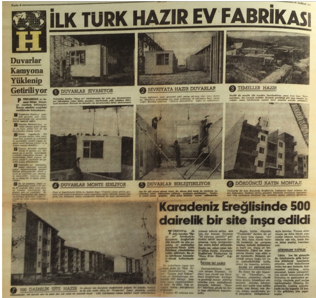
Şekil 4.13. Erdemir Lojmanlarının inşaat süreci hakkında çıkan bir haber.
