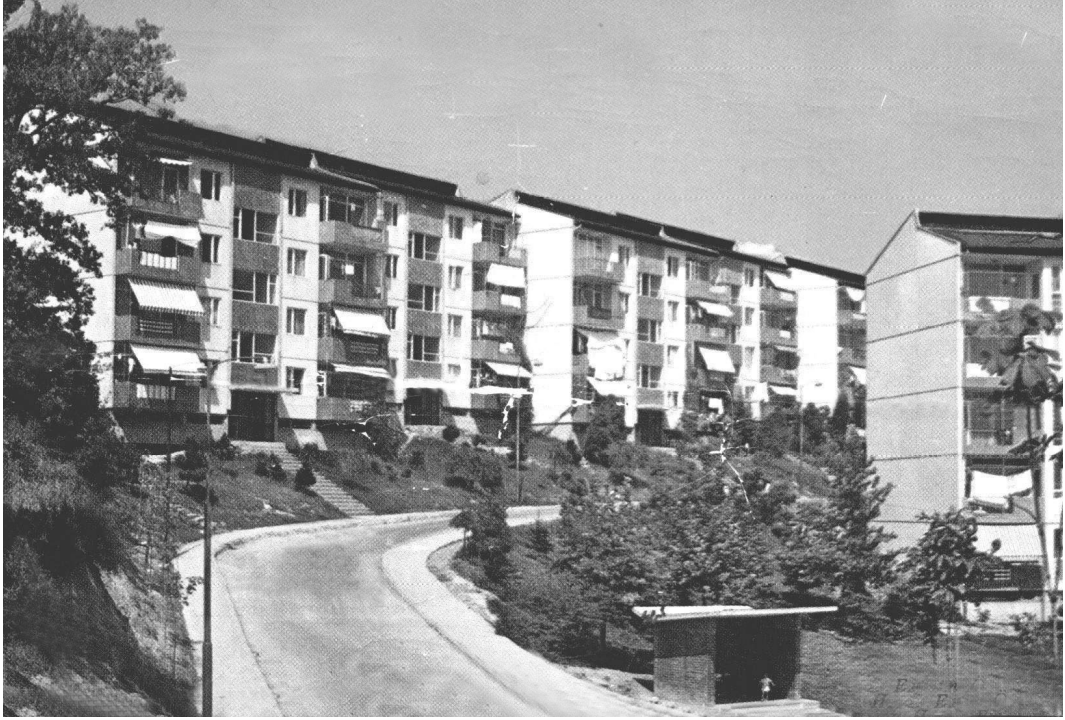
Şekil 4.10. Yıkılan Prefabrik 60 Evler.
