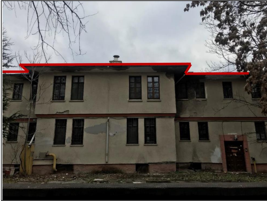
Şekil 5.130 : Saraçoğlu Mahallesi bina tipolojisi (yazar arşivi, 2020).
