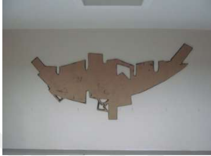
Foto 109: Suntanın duvara monte edilmesi
