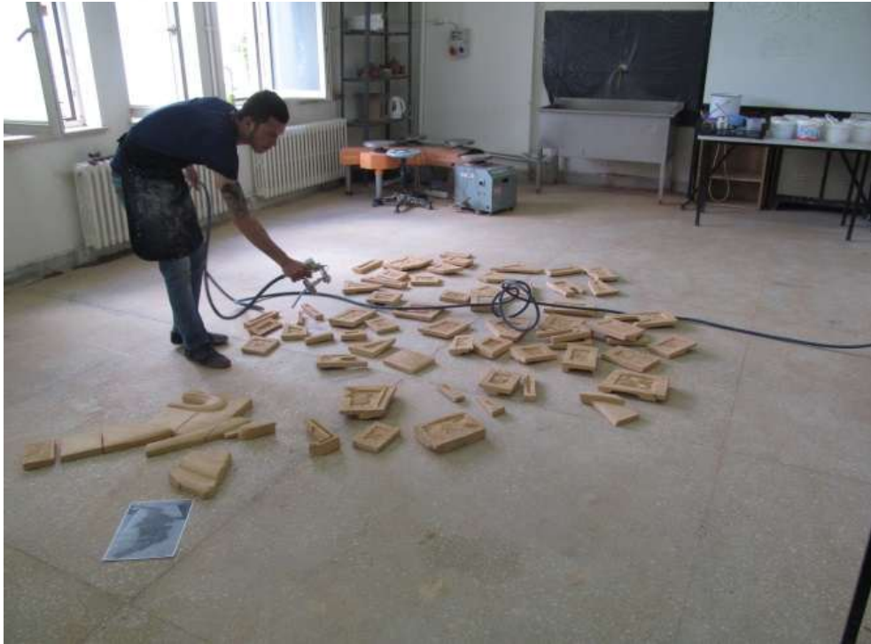
Foto 91: Pano parçalarının kompresör ile hava verilerek temizlenmesi
