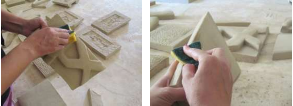
Foto 64 – 65: Pano kesim sonrası rötuş çalışmaları
