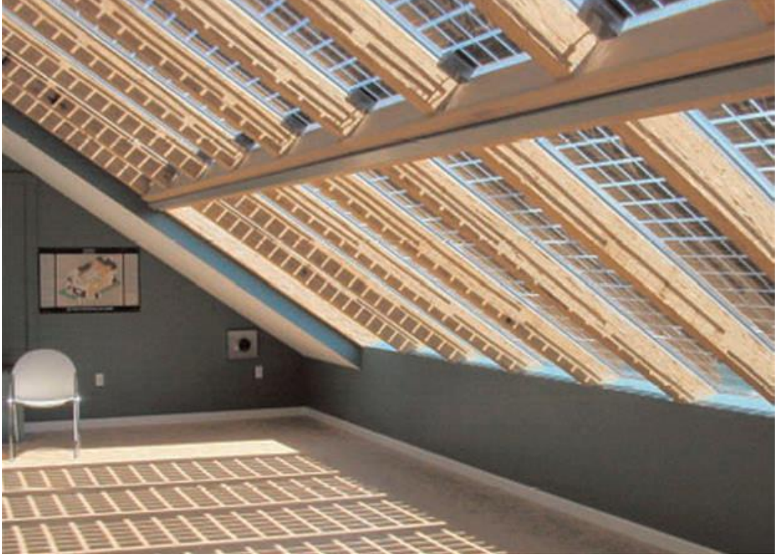
Şekil 2.18. Çatıya entegre edilmiş geçirgen PV modüller [21].
