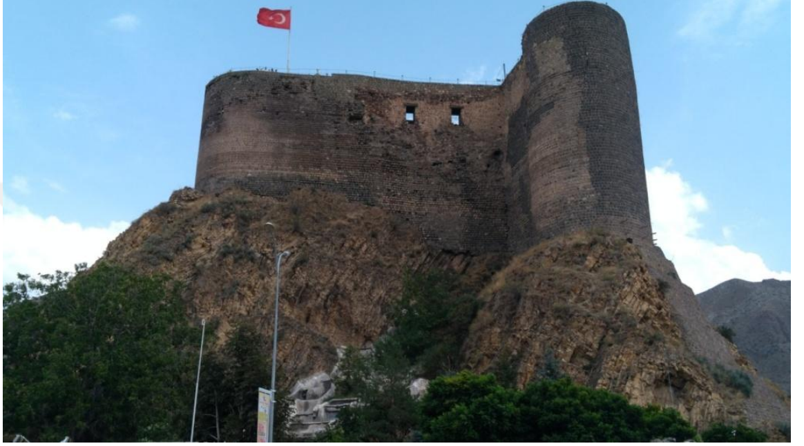
Şekil 3. 16. Oltu Kalesi'nin kuzeyden görünümü (Fotoğraf: Y. E. Durmaz, 2019)
