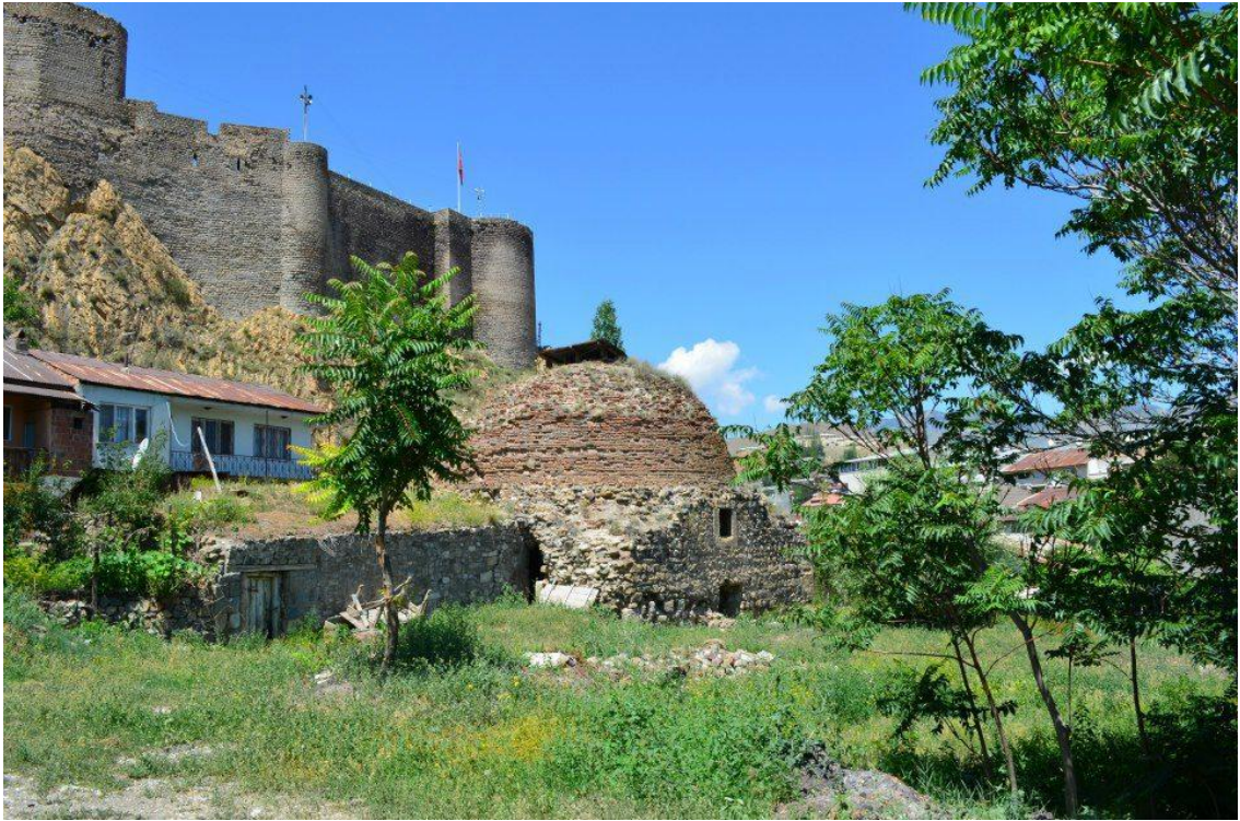
Şekil 3. 30. Selçuklu Hamamı'nın güneydoğudan görünümü (Fotoğraf: Y. E. Durmaz, 2018)
