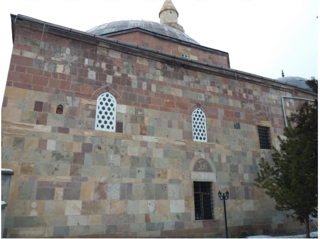
Şekil 3. 64. Arslan Paşa Camii doğu cephesi (Fotoğraf: Y. E. Durmaz, 2019)
