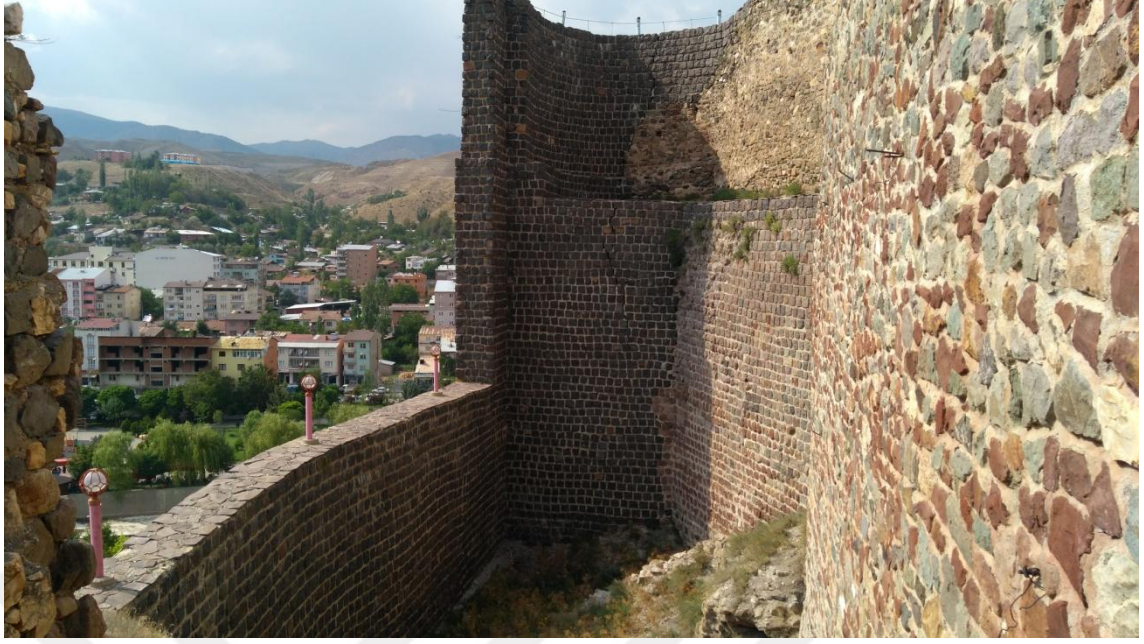
Şekil 3. 9. 2 no'lu burç, içeriden görünüm (Fotoğraf: Y. E. Durmaz, 2019)
