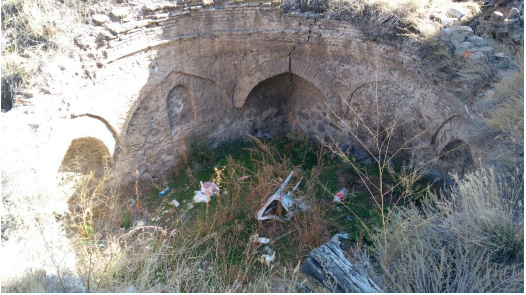
Şekil 3. 34. Selçuklu Hamamı'ndaki tromplardan bir görünüm (Fotoğraf: Y. E. Durmaz, 2019)
