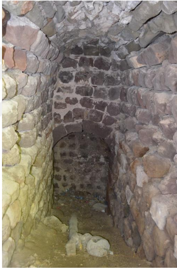
Şekil 3. 12. Türbe karşısındaki tünel girişi (EKTVKK Arşivi, 2016) 12
