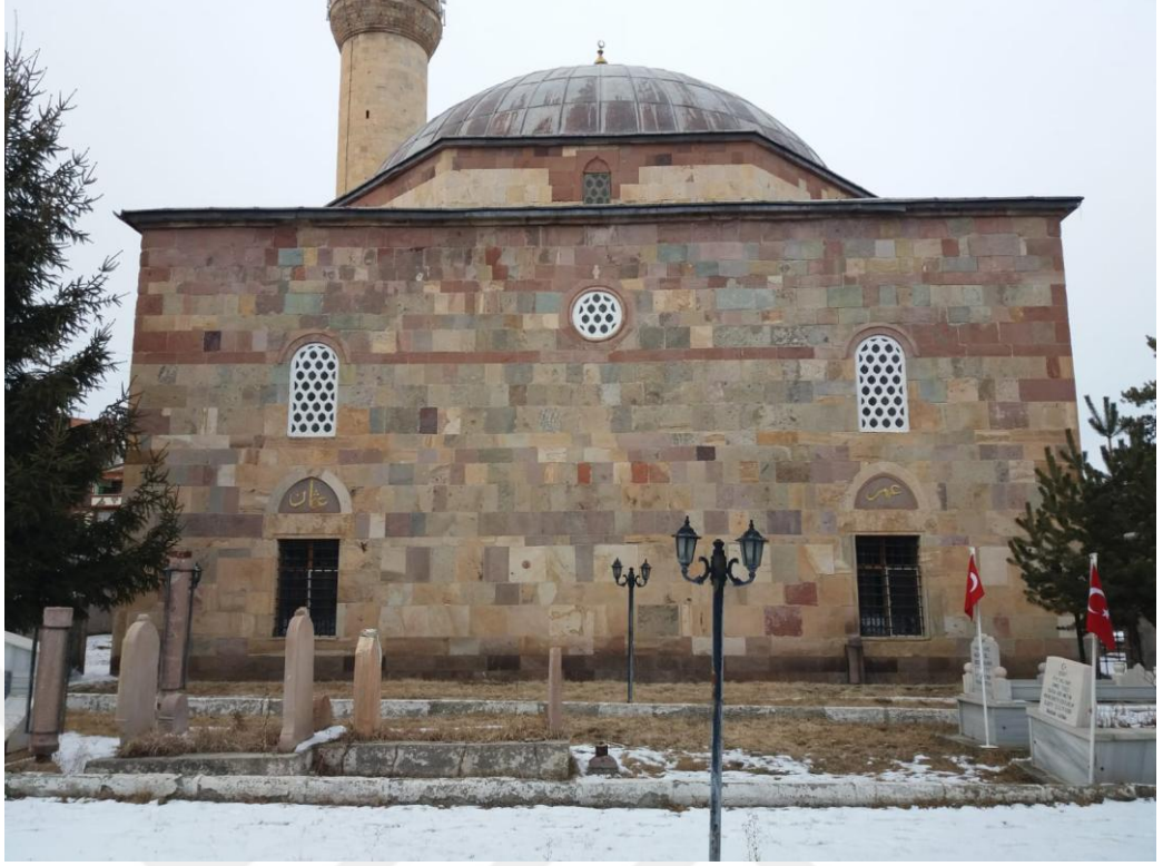
Şekil 3. 63. Arslan Paşa Camii güney cephesi (Fotoğraf: Y. E. Durmaz, 2019)
