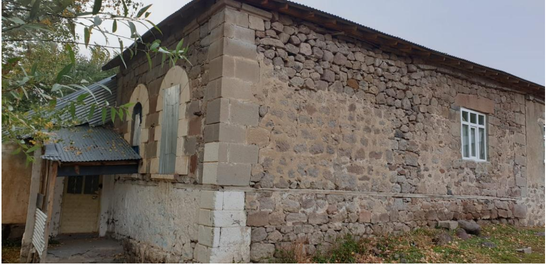
Foto 12: Sonradan Eklemeler Yapılmış, Yezidilere Ait Bir Ev(Kılıçgediği Köyü)
