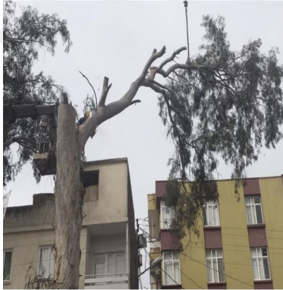
Şekil 1.9. Kesilen dalın halatla tutulması
