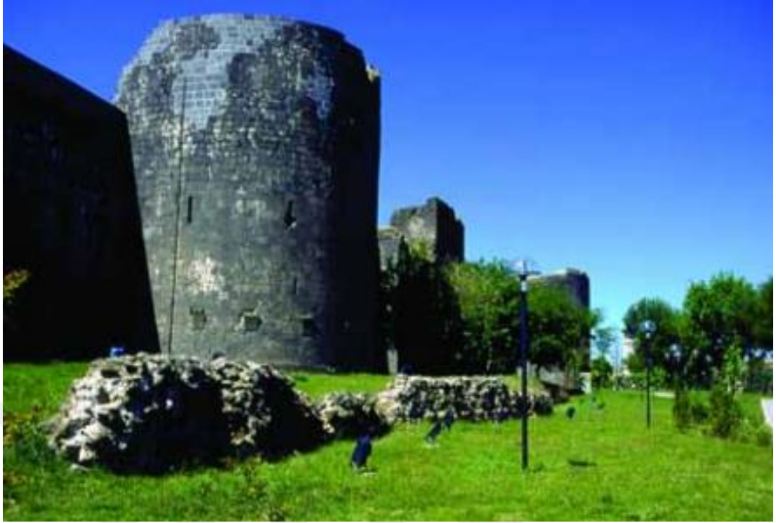
Fotoğraf 11. Amid İç Kalesi'nin kuzeydoğusundaki dış sura ait kalıntılar. (Canan Parla, “Diyarbakır Surları ve Kent Tarihi”, ODTÜ MFD , 22/1, 2005, s. 57-84).
