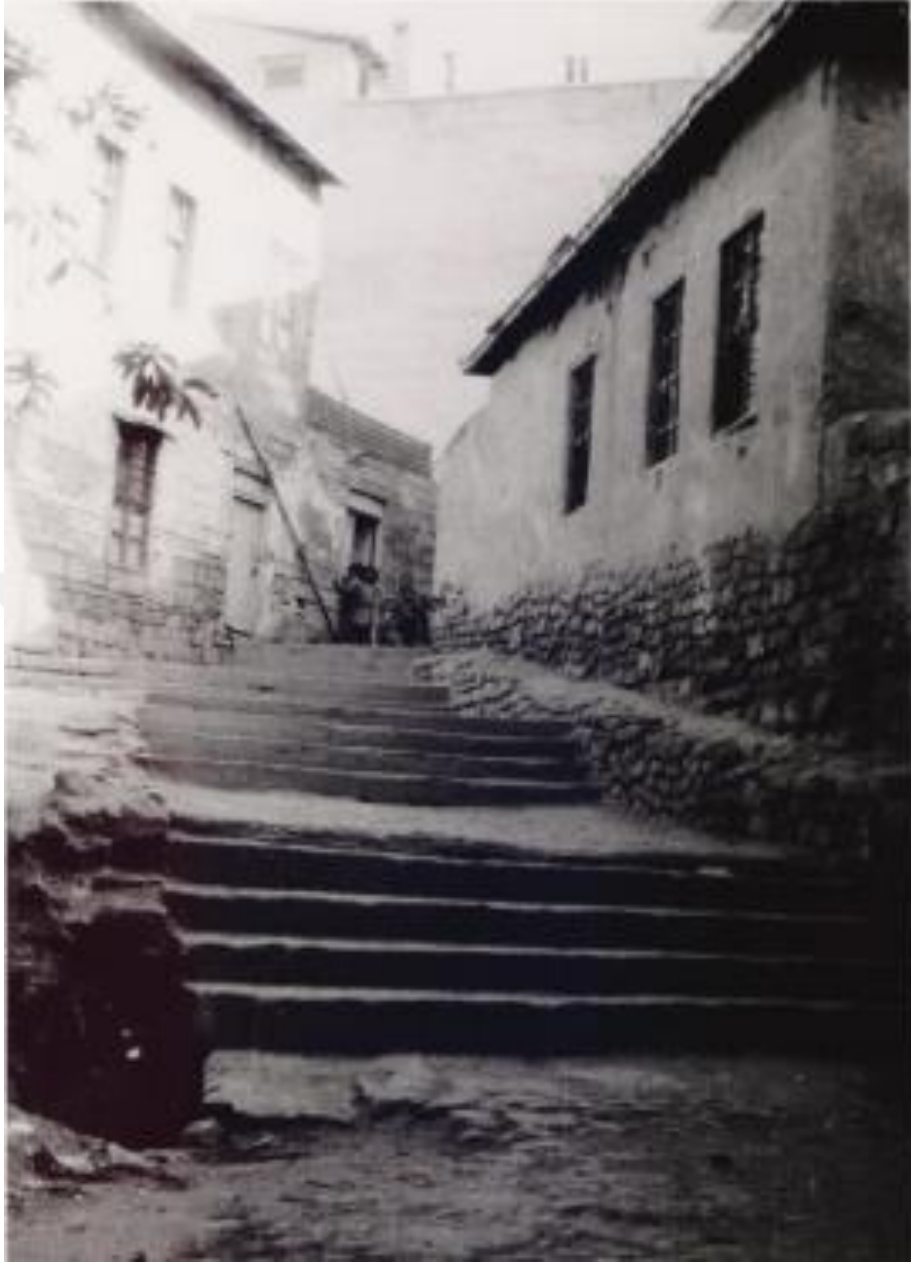
Fotoğraf 3. Aksaray, Dere Mahallesi, kale sur duvarları üzerine sonradan inşa edilen merdivenler (1975). (Bekir Deniz, “ Aksaray Kalesi ”, Selçuklu Medeniyeti Araştırmaları Dergisi , S:2, 2017, s. 225-257).
