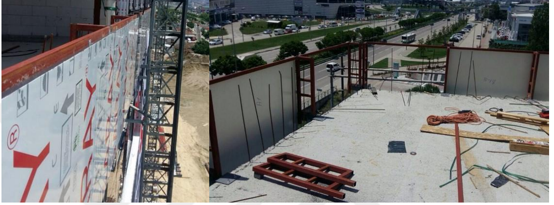
Şekil 2.73. Alüminyum kompozit panel montaj örneği (Anonim 2017).
