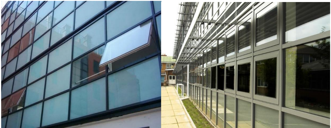
Şekil 2.28. Kapaklı cephe içi açılır kanat uygulama örnekleri (Anonim 2019o)
