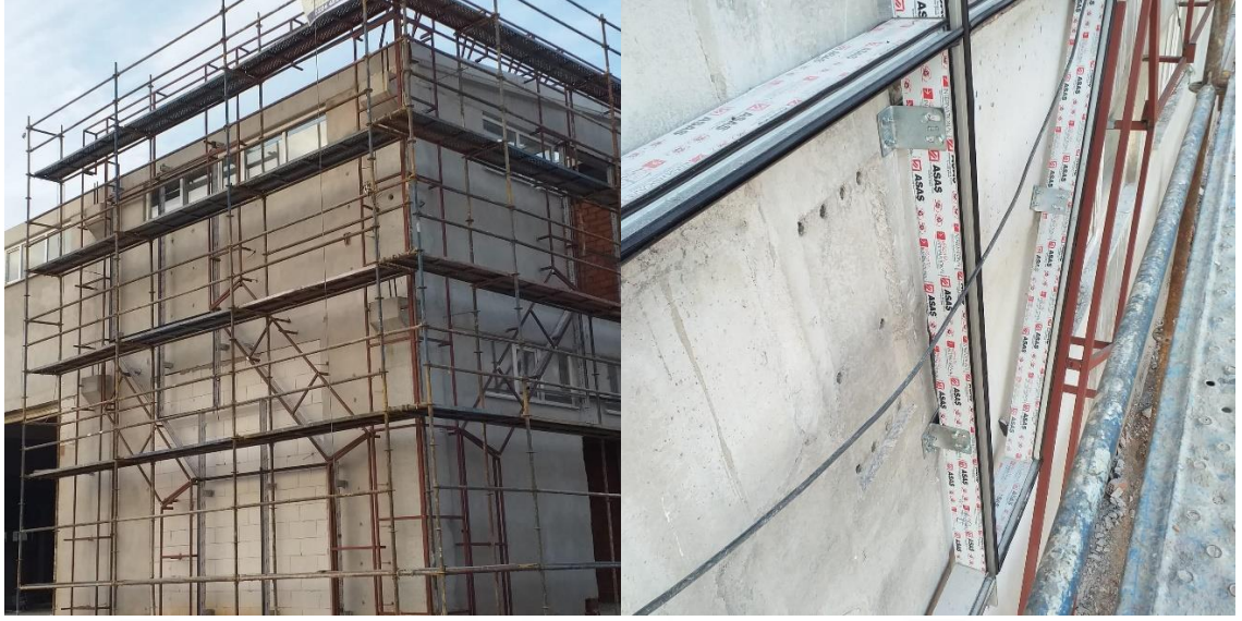
Şekil 2.13. Hafif asma sistem montaj örneği (Anonim2019)
