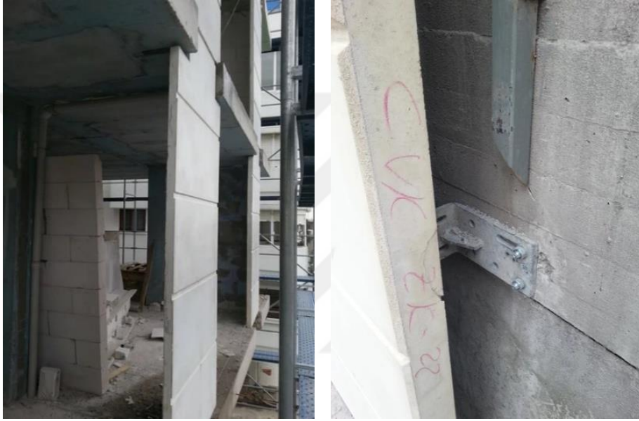
Şekil 2.12. Prekast beton uygulaması (Anonim 2019g)
