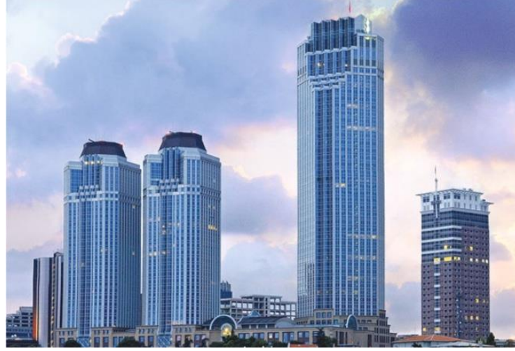
Şekil 2.20. Türkiye İş Bankası İdari Binası – İstanbul (Anonim 2019i)
