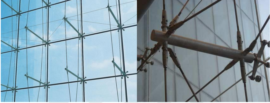
Şekil 2.40. Kablo taşıyıcılı sistem örneği (Anonim 2019u)
