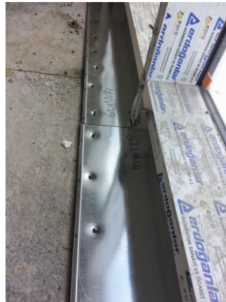
Şekil 2.61. Şap altı sacı uygulama örneği (Anonim 2019af)
