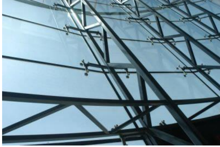
Şekil 2.34. Kare kesitli pylon örneği (Anonim 2019s)
