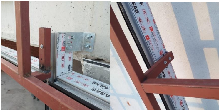
Şekil 2.72. Ankraj uygulaması ve saplama ile cephe sabitlemesi (Anonim 2018).
