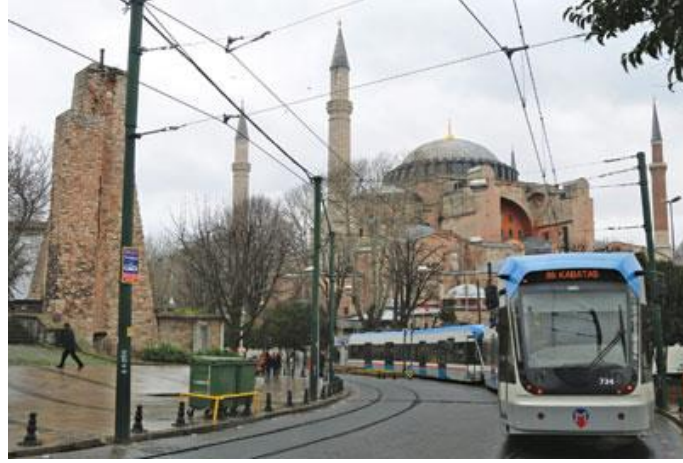
Şekil 3.2 : Sultanahmet Meydanı'ndaki katener direkleri ve kabloları.
