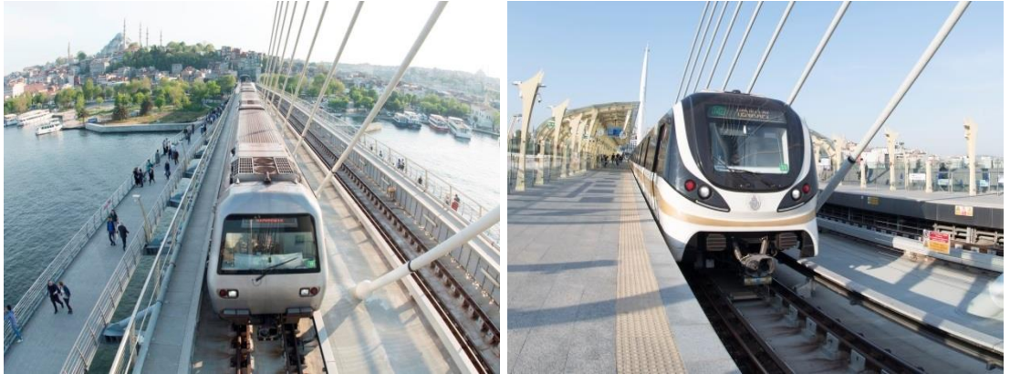
Şekil 2.6 : M2 metro hattı Haliç geçiş köprüsü Rotem metro araçları.
