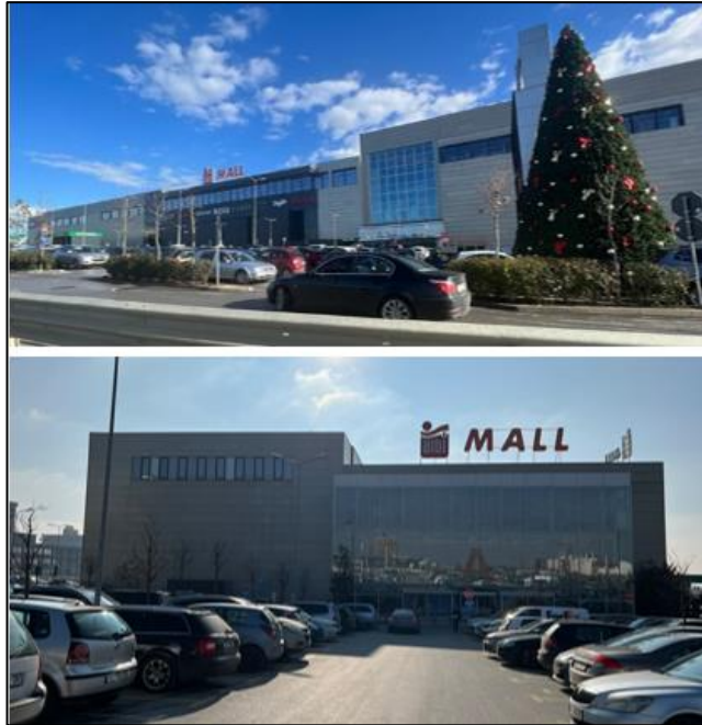
Şekil 5. 17 Albi Mall dış cephe görünümü (Gaş, 2022)
