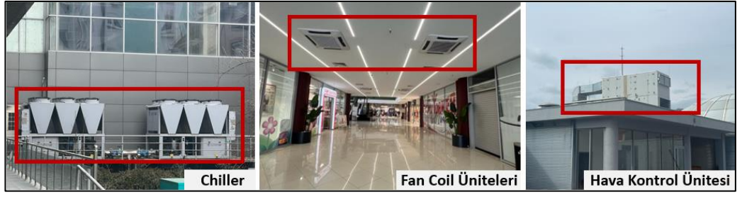
Şekil 5. 64 Mall of Mitrovica'da kullanılan HVAC sistemleri (Gaş, 2023)
