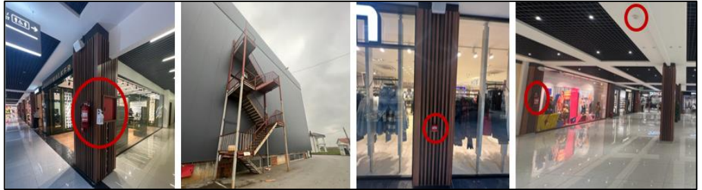
Şekil 5. 39 Ring Mall'da yangın güvenlik sistemleri (Gaş, 2022)
