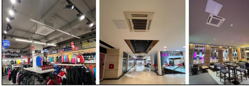
Şekil 5. 46 Albanica Mall’da tavan tipi fankoil üniteleri (Gaş, 2022)
