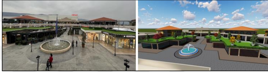
Şekil 5. 34 ABİ Çarşıa çatı yüzeyine suni çim halı uygulaması (Gaş, 2022; Bublaku, 2022)
