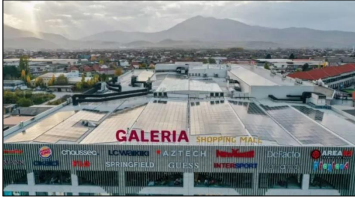
Şekil 5. 21 Galeria Mall, çatı üzeri güneş panel kurulumu (Retail See, 2022)
