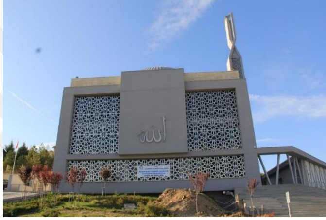
Foto. 221: Alacaatlı Uluyol Cami, Güney Cephe, Kişisel Arşiv, 2019.
