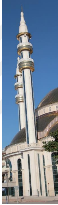
Foto. 217: Güneşevler Merkez Cami, Minare, Kişisel Arşiv, 2019.
