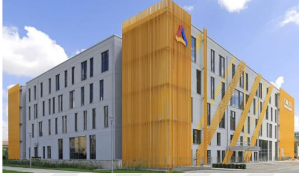
Foto. 60: TOBB ETÜ Teknoloji Merkezi Binası. (dab.com.tr/projeler/tobb-etu-teknoloji-merkezi-binası, Erişim Tarihi: 16.01.2020).
