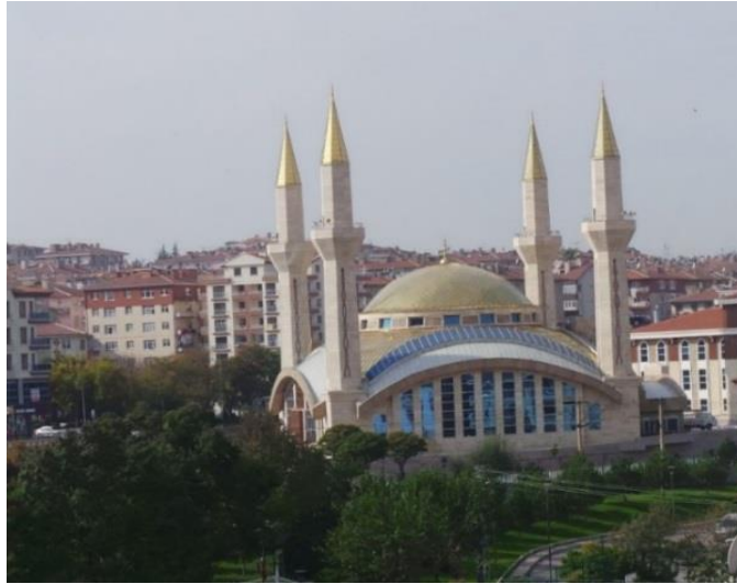
Foto. 202: Mamak Merkez Cami, Doğu Cephe, Cami Derneği, 2019.
