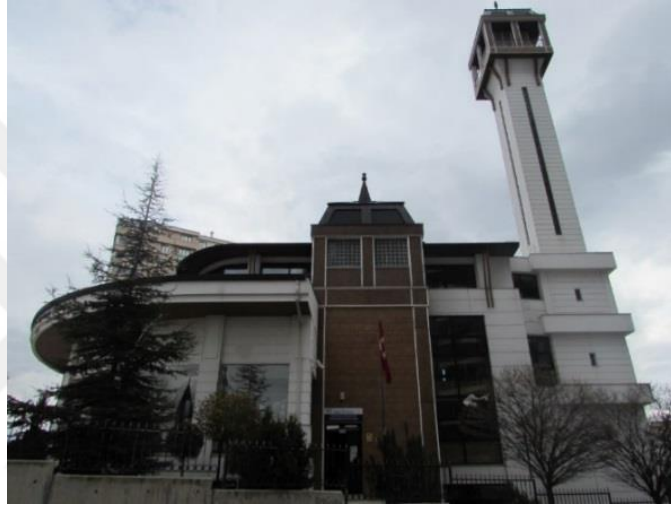
Foto. 162: Hisarcıklıoğlu Beştepe Cami, Kuzey Cephe, Kişisel Arşiv, 2019.
