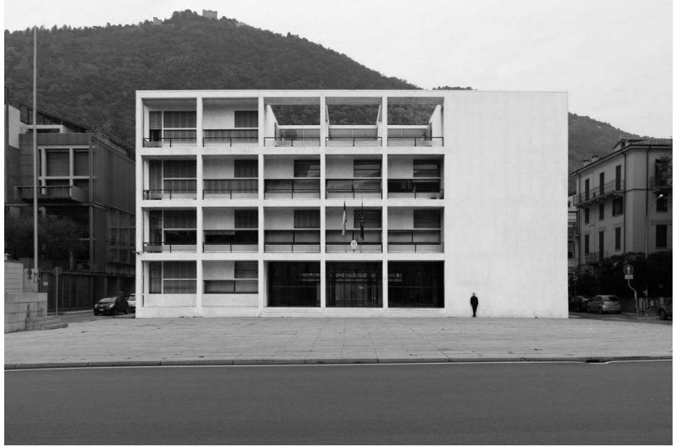
Şekil 2.2: Casa Del Fascio ve Faşist Parti mitinglerinin yapıldığı meydana bakan cephesi (Wikimedia Commons arşivinden, 2017)
