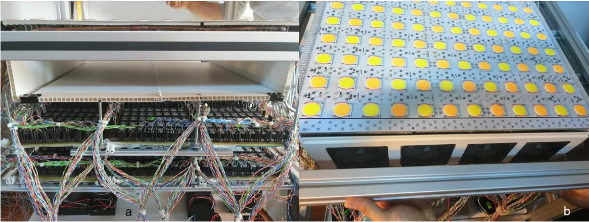
Şekil 4.23 (a) Fan kabininin görünümü, (b) Fanların kabine montajı
