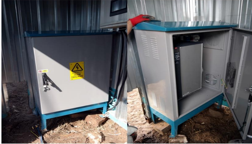
Şekil 3. 8. Sürücülü güç panosu
