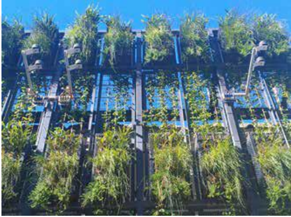
Şekil 2.8 Canlı duvar ve yeşil cephe sistemi uygulaması (FCS, 2013)
