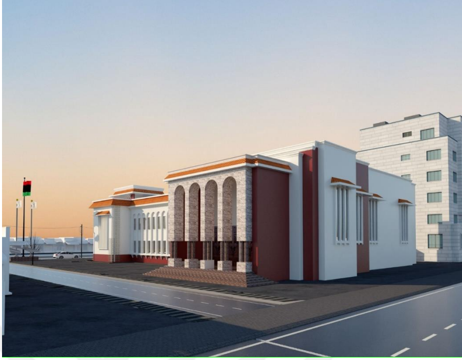
Şekil 3.13 Zliten Belediye binası doğu cephesi
