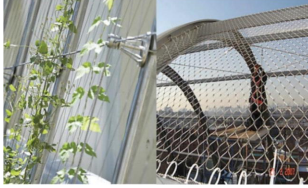
Şekil 2.11 Kablo ve tel halat ağ sistemleri (URL-5, 2019)
