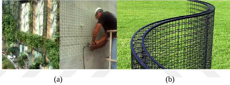
Şekil 2.10 Modüler duvara asılı kafes (a), kavisli kafes (b) (URL-4, 2019)
