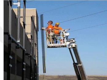
Golden, CO'daki çok katlı bir binaya monte edilen sert, hafif, üç boyutlu paneller
