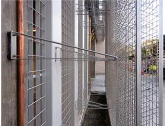
Duvar destekli, modüler üç boyutlu paneller, ayırma braketleri ile bitkileri duvardan uzak tutmak için erişim sağlar, Oakland, CA
