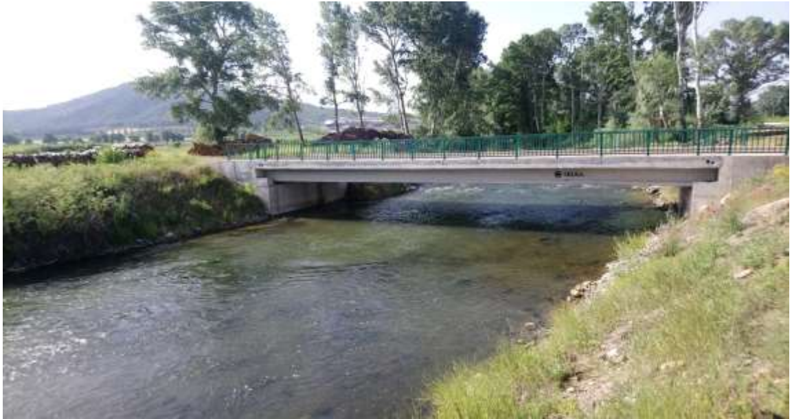
Şekil 6.22. Fidanlık Köprüsü tamamlanmış hali
