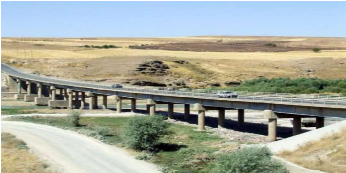
Şekil 4.3. Adıyaman Göksu köprüsü, (URL 7, 2020).
