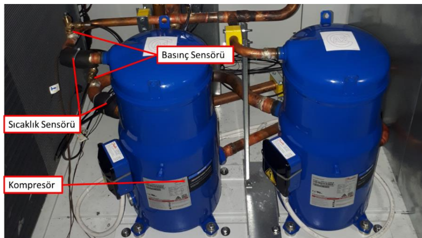
Şekil 3.13 Kompresör tarafındaki sıcaklık ölçümleri
