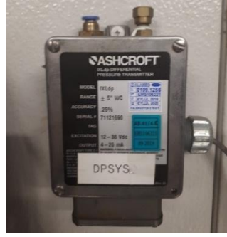
Şekil 3.6 Fark basınç sensörü
