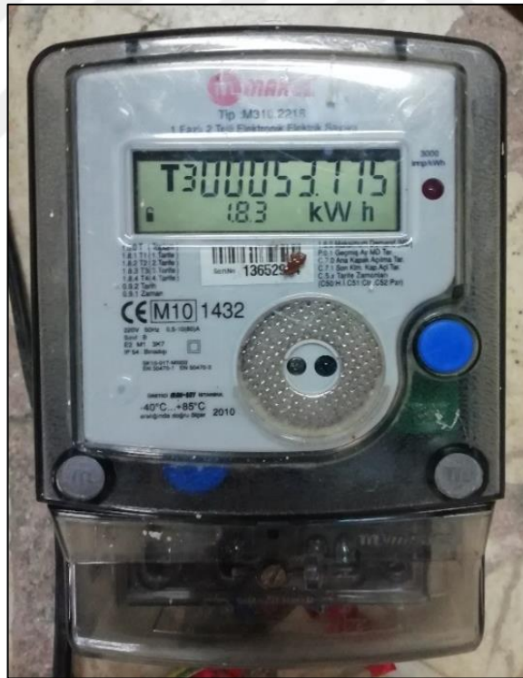
Şekil 4.27. Makel M310.2218, tek fazlı, elektronik elektrik sayacı
