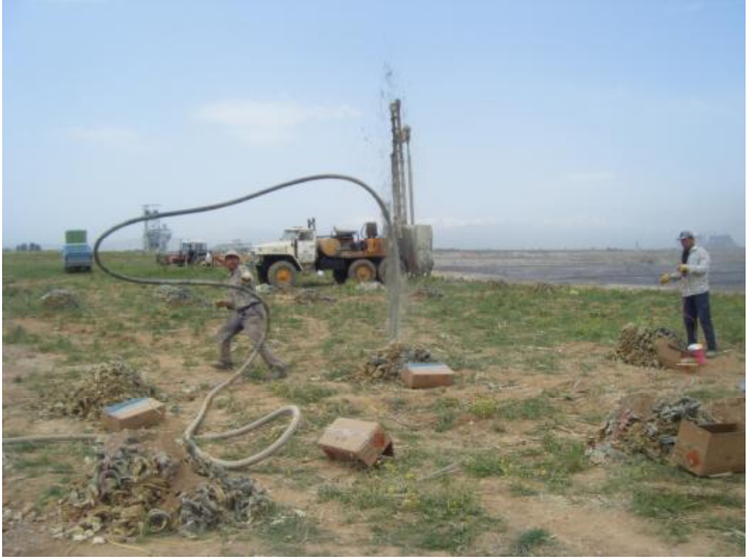
Şekil 4.4. Delik içindeki suyun kompresör ile boşatılması işlemi
