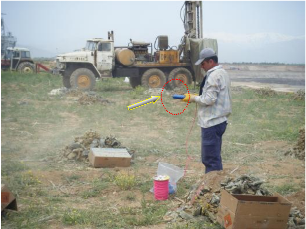
Şekil 4.5. İlk yemleyicinin delik dibine indirilmesi işlemi
