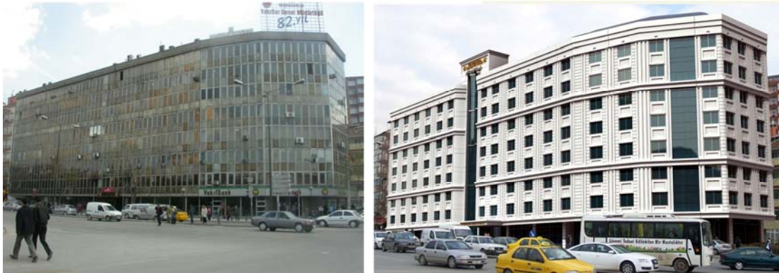
Resim 4.19. Onarım öncesi ve sonrasında eski Vakıflar Genel Müdürlüğü binası [VGM arşivi, 2007-2010]
