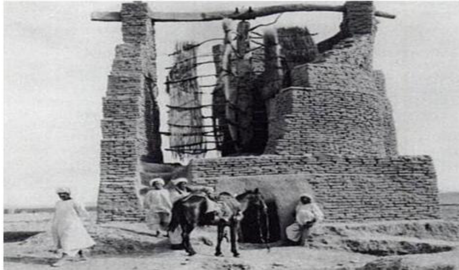
Şekil 3.1. Afganistan'da, tahıl öğütmek amacıyla kullanılan düşey eksenli bir rüzgâr türbini [2]
