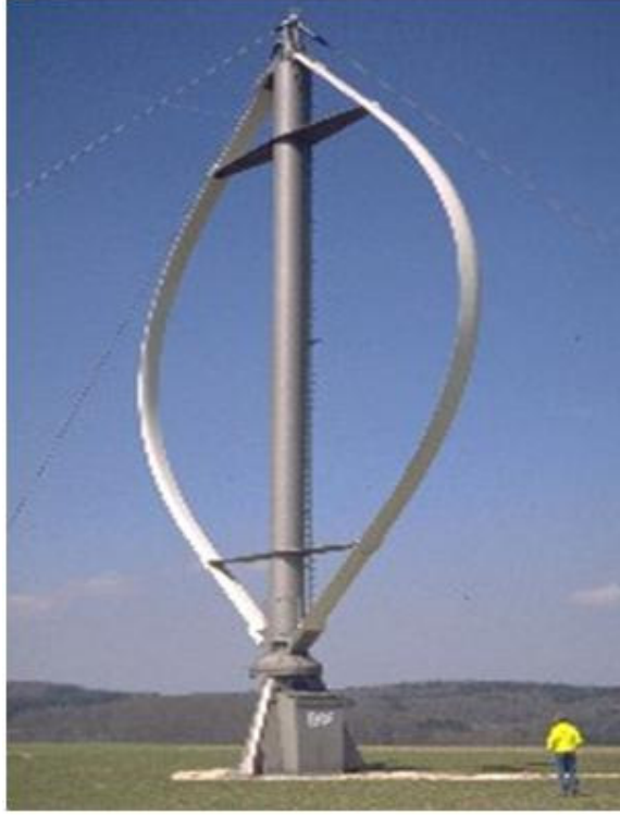
Şekil 3.10. Düşey eksenli bir rüzgâr türbini örneği [35]
