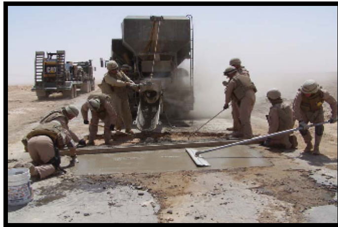
Şekil 2.14. Bombardımandan sonra zedelenmiş zeminin hızlı sertleşen betonla onarımı. (U.S. Government Department of Defense, 2003).
