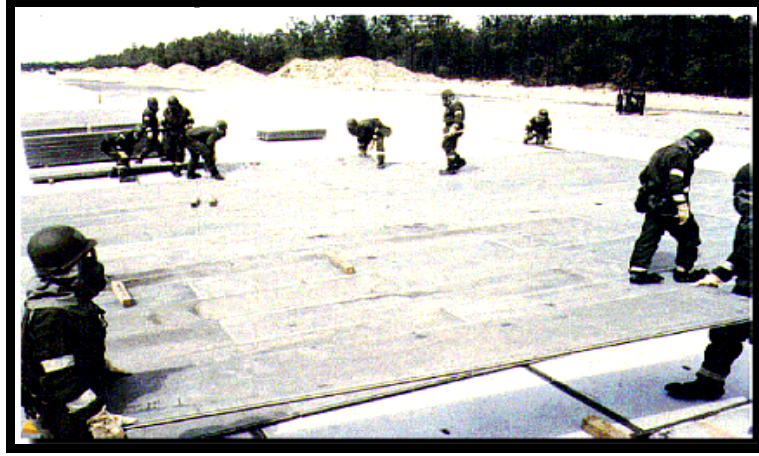
Şekil 2.30. AM-2 alüminyum levha döşeme yöntemi ile hızlı onarım (U.S. Department of The Air Force, 2008 a).
