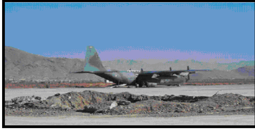
Şekil 2.10. Bombardımandan sonra pist zemininde oluşan büyük bomba çukuru (U.S. Department of The Air Force, 2008 a).
