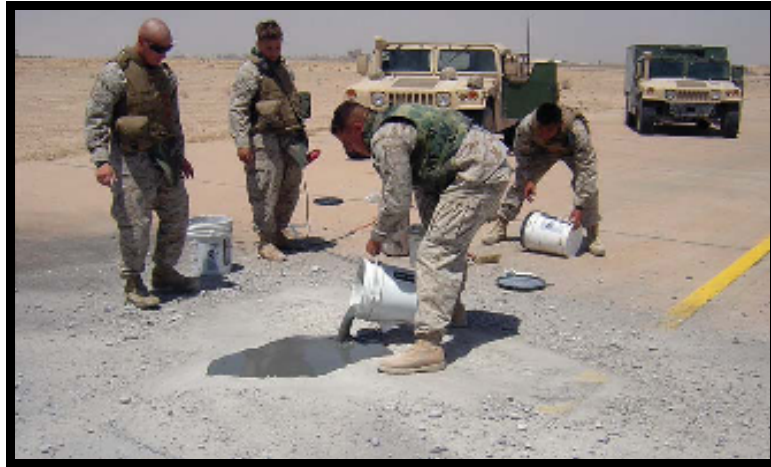
Şekil 3.2. Hasarlı zemine şerbet uygulama (U.S. Department of The Air Force, 1997).
