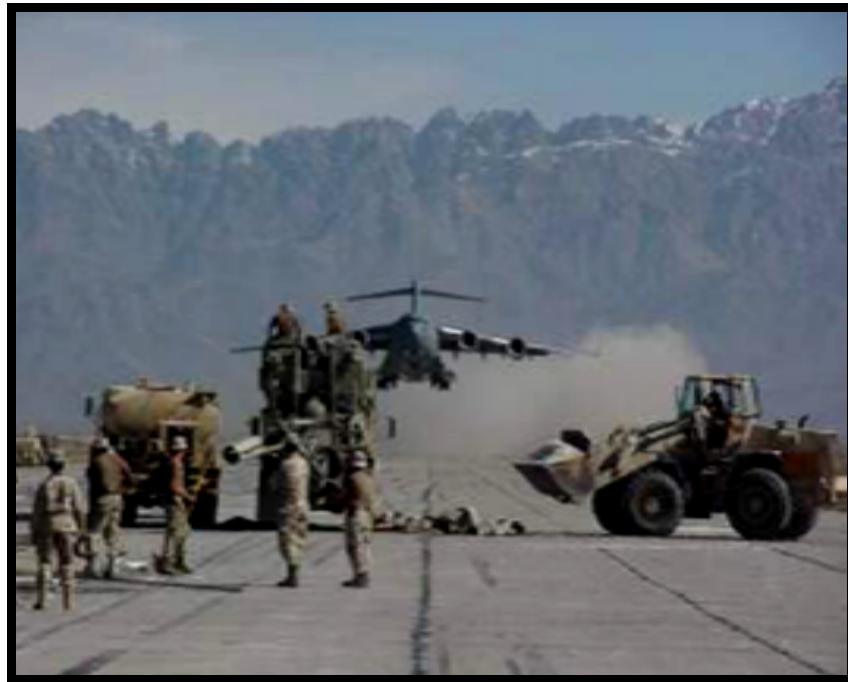
Şekil 1.1. Pist hızlı onarım ekibi çalışması (U.S. Department of The Air Force,1997).
