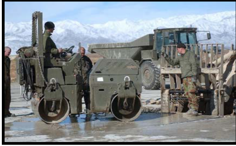
Şekil 2.22. Taş ve çimento şerbeti dolguda titreşimli silindir uygulaması (American Concrete Pavement Association, 2006).
