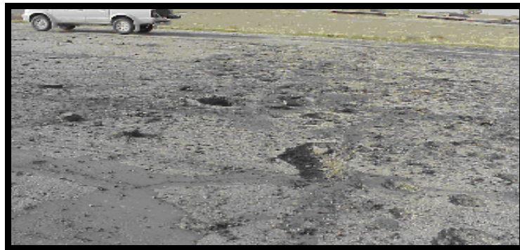
Şekil 2.9. Bombardımandan sonra yer yer zeminde oluşan kaplama zedelenmeleri (U.S. Department of The Air Force, 2008 a).
