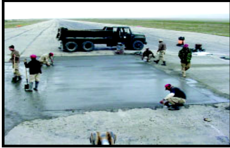
Şekil 2.15. Bombardıman sonrasında zedelenen alanın onarıldıktan sonraki görünümü (U.S. Government Department of Defense, 2003).
