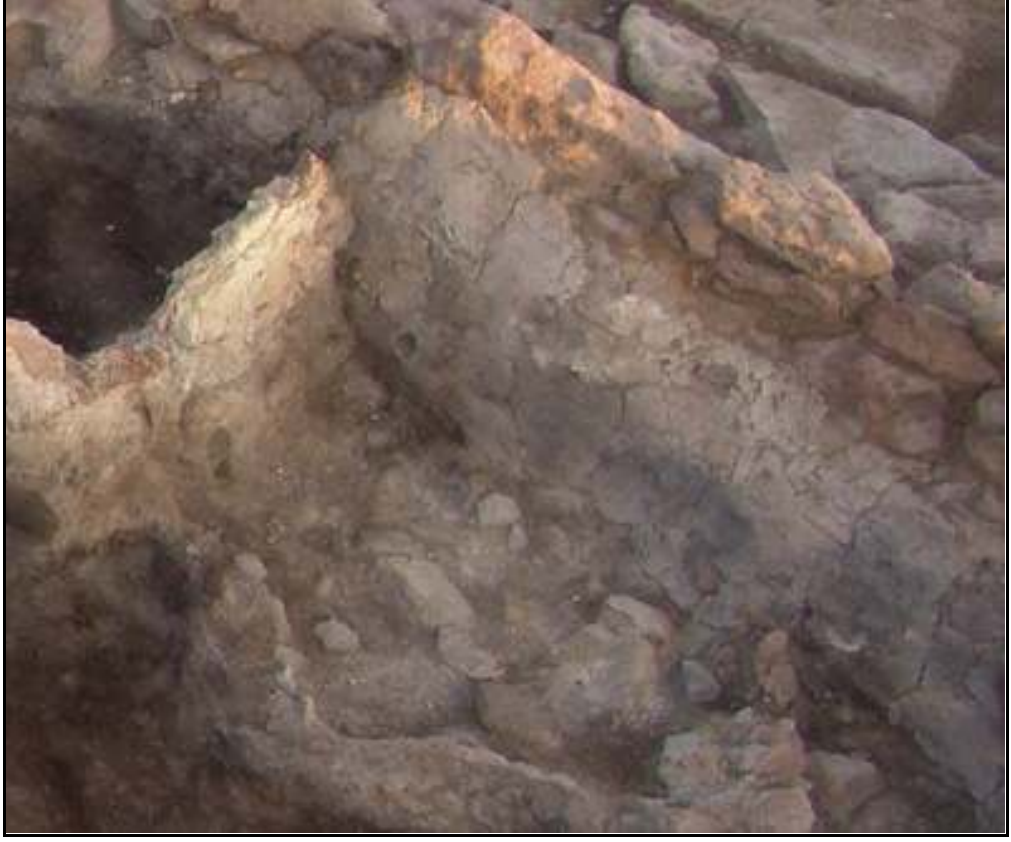
Resim 14: 7G/ M5-6 Yangın Sonucu Beyaza Dönüşmüş Duvar Sıvası Örneği
