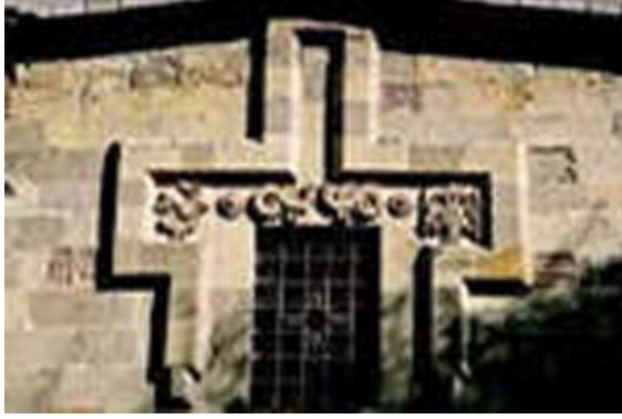
Fotograf 41: Aziz Basil Şapeli Dış Duvar*
