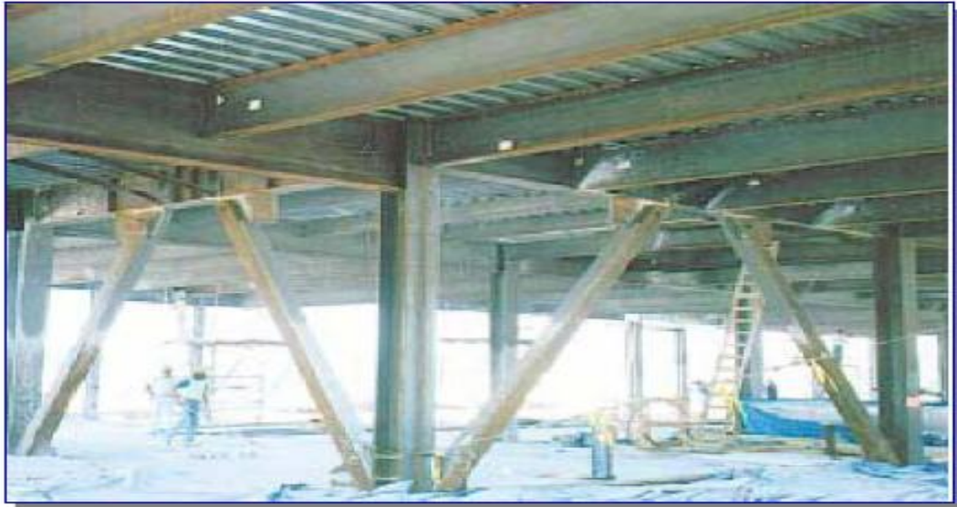
Şekil 7.1 Yapı Genel Görünüşü
