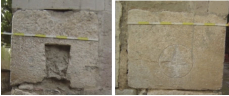
Resim 192- 193: Abdalata köyü camisi, güneybatı cephe köşesi, vida ağırlık taşı yan görünüşleri
