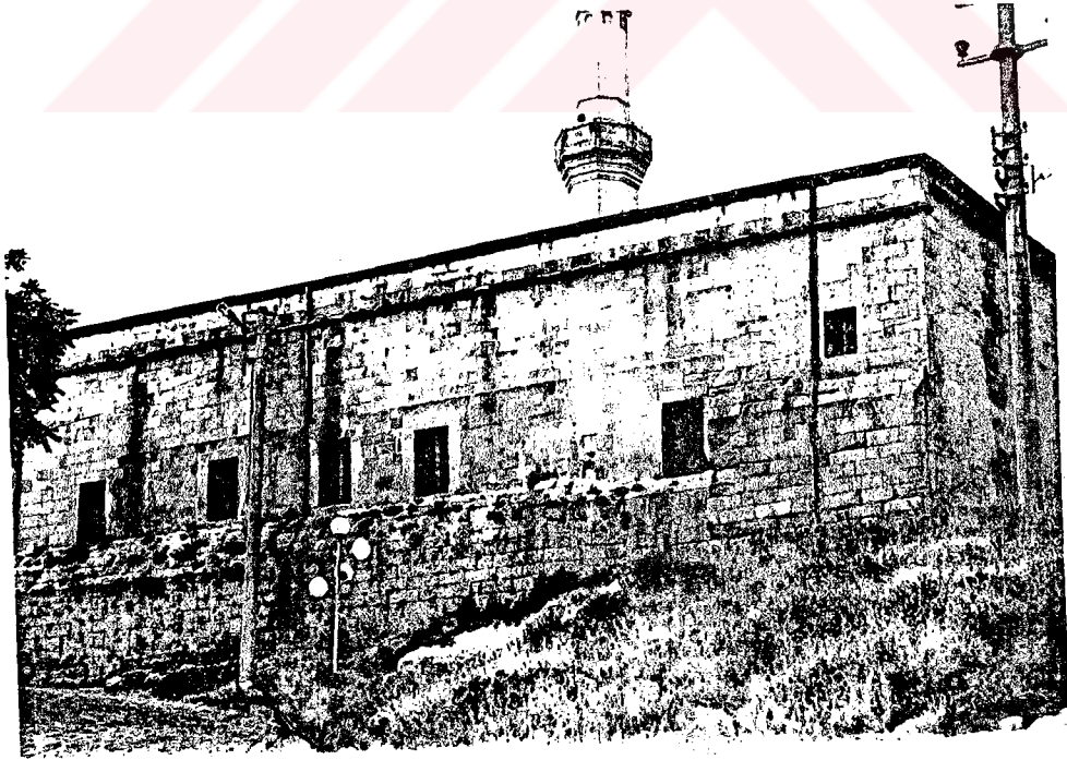
Resim No 3- Ürgüp İbrahim Bey Camisinin Doğu Cephesinden görünüşü
