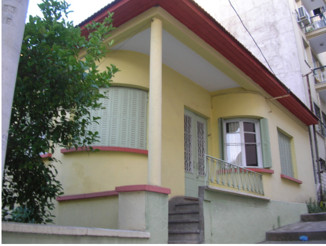
(Resim:9) 179 Sk ile 213 Sk köşesindeki ev, No. 27, Konak
