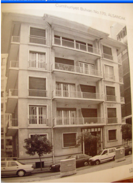
(Resim:22) T.C. Merkez Bankası Misafirhanesi (1950'lerin ilk yarısı) Cumhuriyet Bulvarı No.170, Alsancak (Fotoğraf: İzmir Mimarlık Rehberi s.137)
