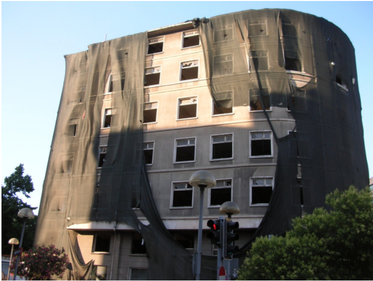
(Resim:14) Atlas Oteli (1958) , Şair Eşref Paşa Bulvarı No.1/1, Çankaya
