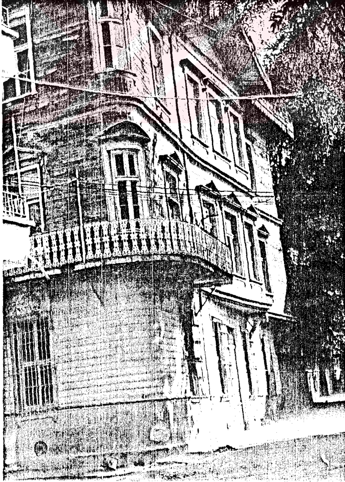
Foto 47: Yapımında ahşap ve taş malzemenin kullanıldığı Osmanlı dönemine ait, bugün Ticaret Lisesi olarak kullanılan bir bina.
