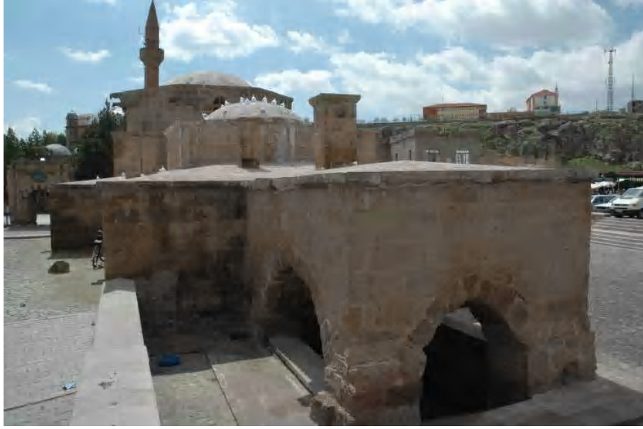
Fot.2.257. İncesu Kara Mustafa Paşa Hamamı Külhan Kısım
