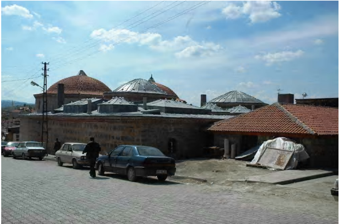
Fot.2.151. Vezirköprü Çifte Hamam
