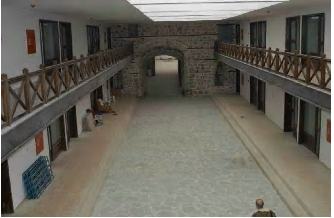
Fot.2.77. Bilecik-Vezirhan Köprülü Mehmet Paşa Kervansarayı İç Mekanın Kuzey Kısmı
