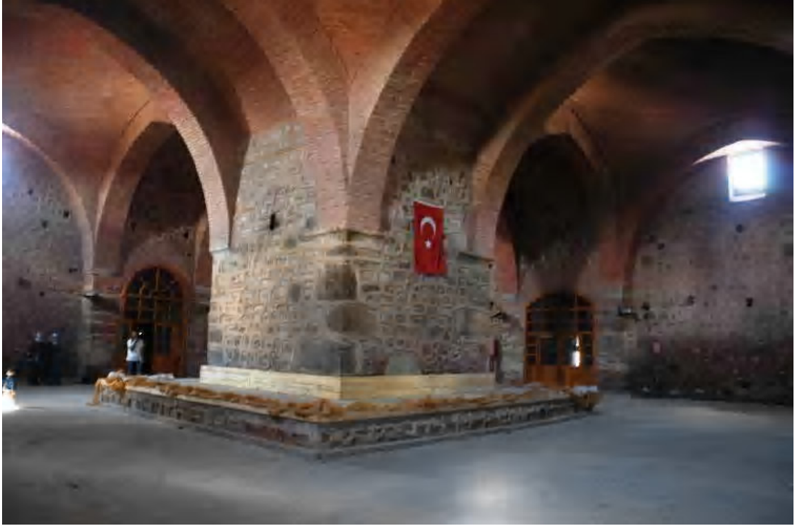
Fot.2.137. Vezirköprü Bedesteni İç Mekan
