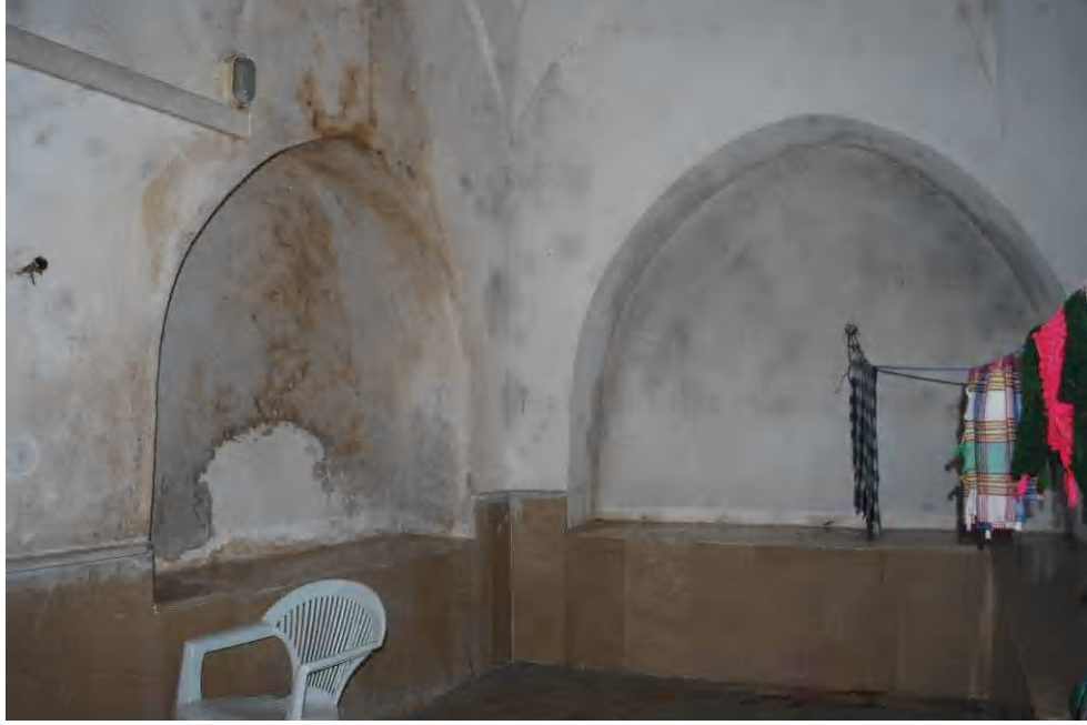
Fot.2.131. Vezirköprü Kale Hamamı Soğukluk Mekanı Doğu Bölümü
