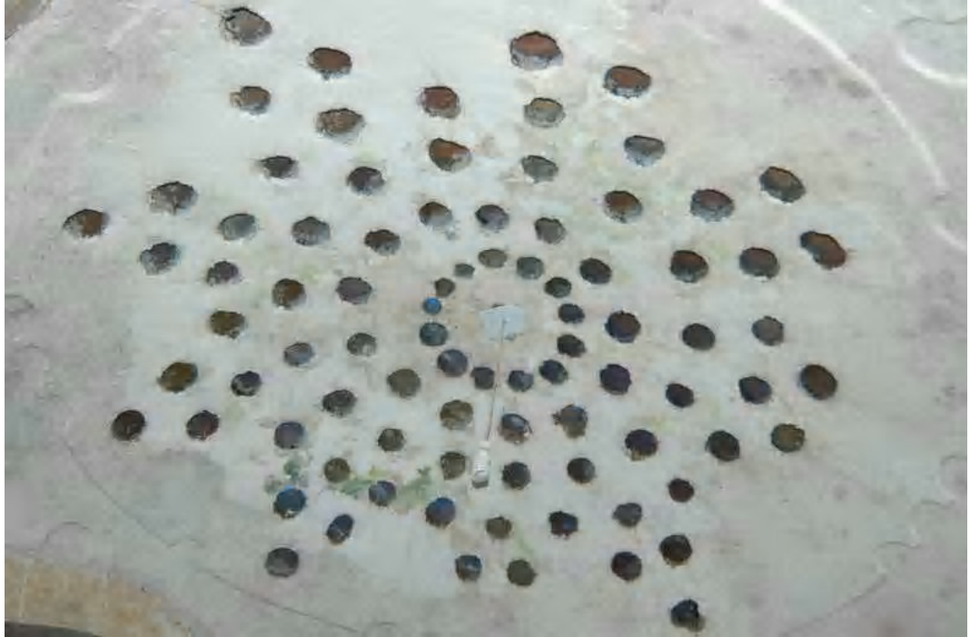
Fot.2.48. Cısr-i Şuğur Köprülü Mehmet Paşa Hamamı Sıcaklık Bölümü Kubbesi Üzerindeki Işık Gözleri
