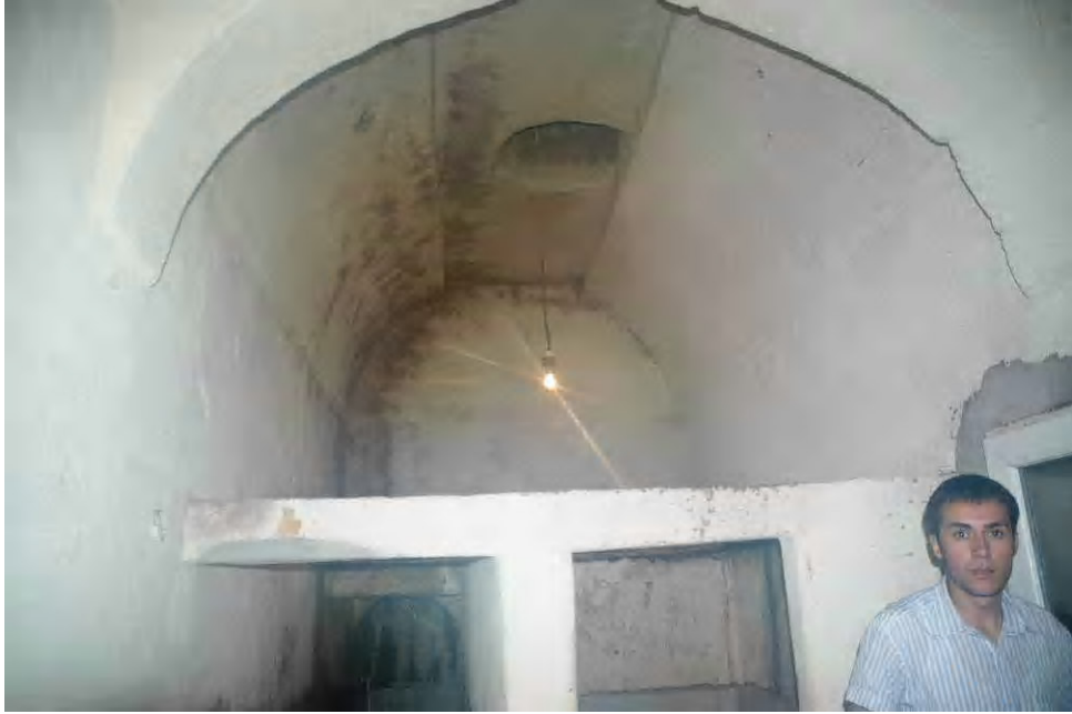
Fot.2.34. Gümüşhacıköy Köprülü Mehmet Paşa Hamamı Ilıklık Bölümü
