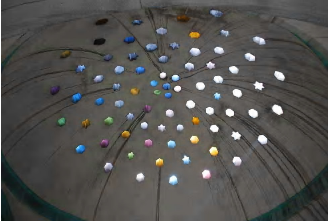
Fot.2.277. İzmir Yeşildirek Hamamı Soyunmalık bölümü kubbesi
