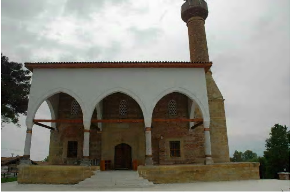
Fot.2.203. Narice Abide Hanım Camisi Kuzey Cephesi
