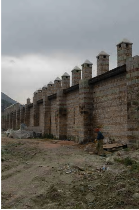
Fot.2.73. Bilecik-Vezirhan Köprülü Mehmet Paşa Kervansarayı Doğu Cephe
