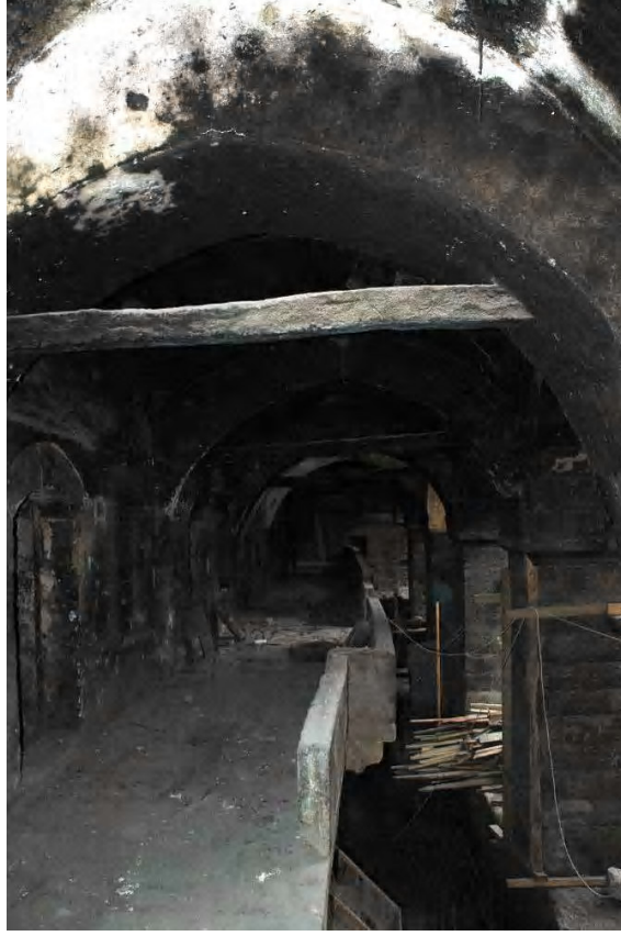
Fot.2.190. Merzifon Taşhan Avlu Kuzey Bölümü Zemin Kat
