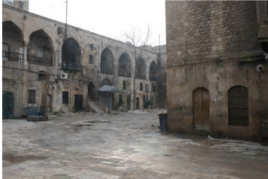
Fot.2.267. Halep Vezir Hanı Avlu Doğu Cephesi
