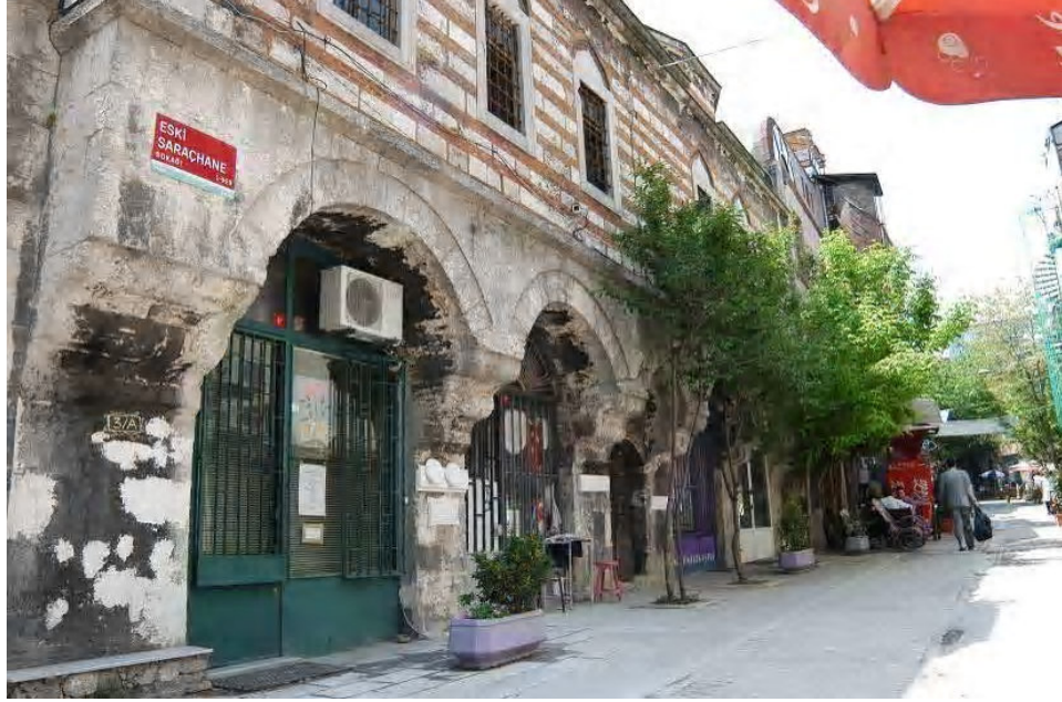
Fot.2.312. İstanbul Amcazade Hüseyin Paşa Külliyesi Dükkânları
