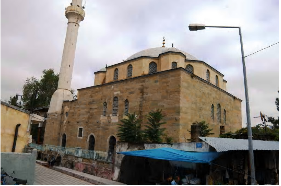
Fot.2.171. Merzifon Paşa Camisi Batı ve Güney Cepheleri
