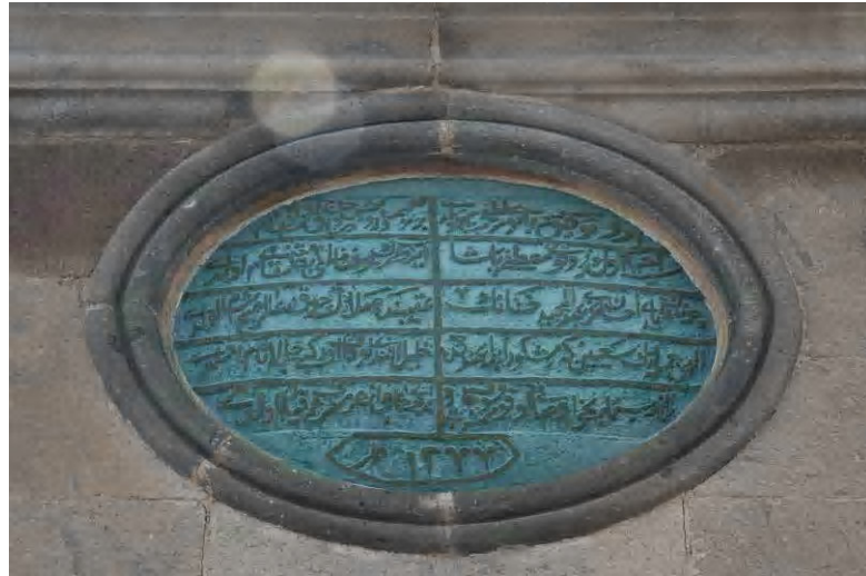
Fot.2.217. İncesu Merzifonlu Kara Mustafa Paşa Menzil Külliyesi Avlu Kapısı Üzerinde Bulunan Onarım Kitabesi
