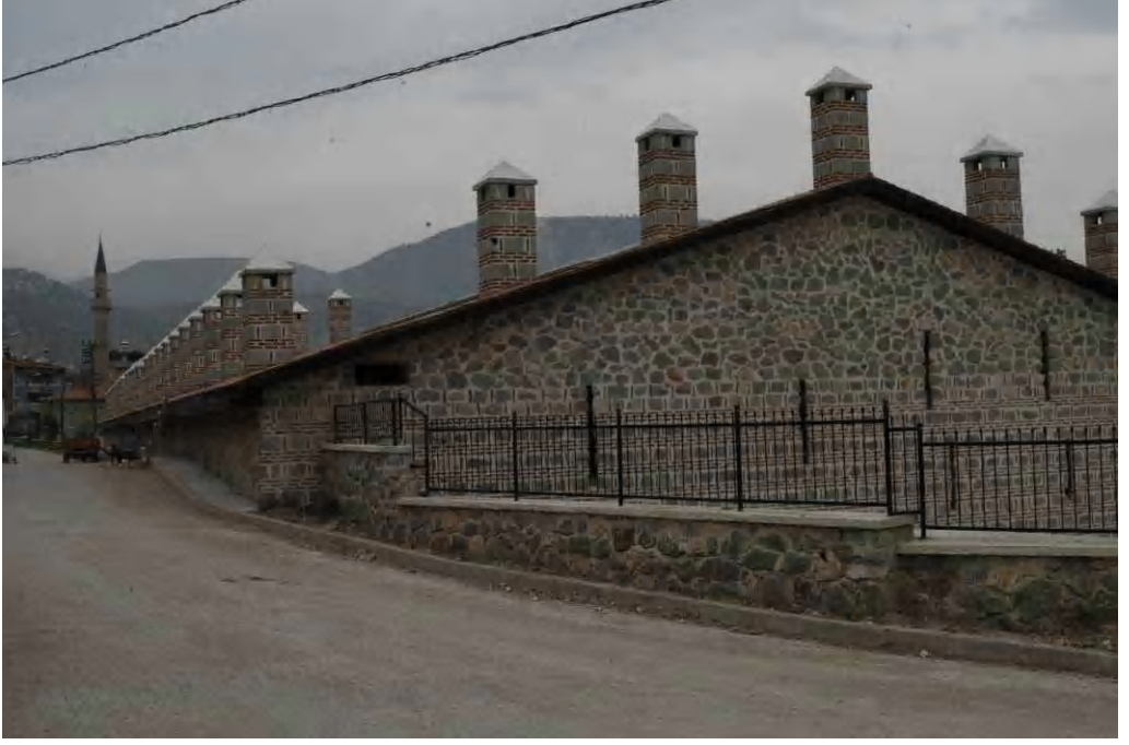
Fot.2. 72. Bilecik-Vezirhan Köprülü Mehmet Paşa Kervansarayı Batı Cephesi
