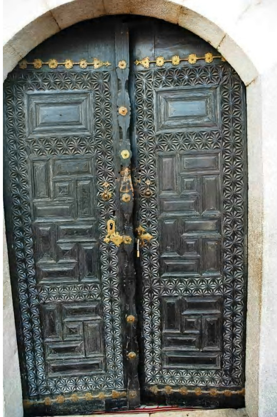
Fot.2.140. Vezirköprü Kale Camisi Ahşap Kapı Kanatları
