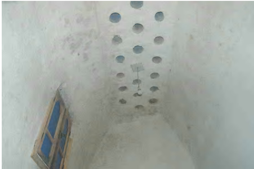
Fot.2.44. Cısr-i Şuğur Köprülü Mehmet Paşa Hamamı Ilkılık Mekanı Güney Bölümü Üst Örtüsü
