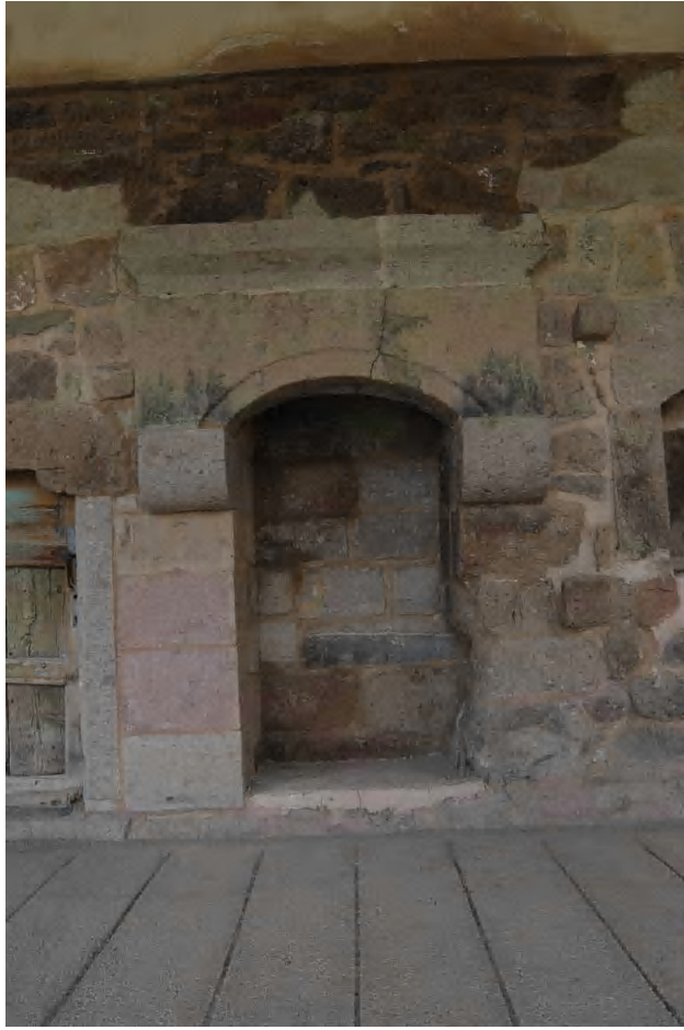
Fot.2.238. İncesu Kara Mustafa Paşa Kervansarayı Avlu Revaklarında Bulunan Ocak Nişleri
