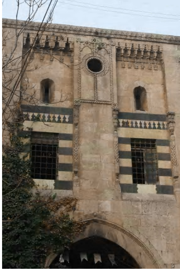
Fot.2.266. Avlu Batı Cephesi Pencere Düzenlemesi
