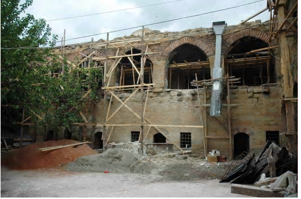
Fot.2.188. Merzifon Taşhan Avlu Batı Bölümü
