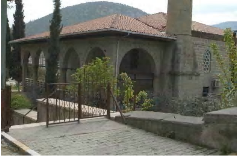
Fot.2.67. Vezirhan Köprülü Mehmet Paşa Camisi Kuzeyden Görünüş
