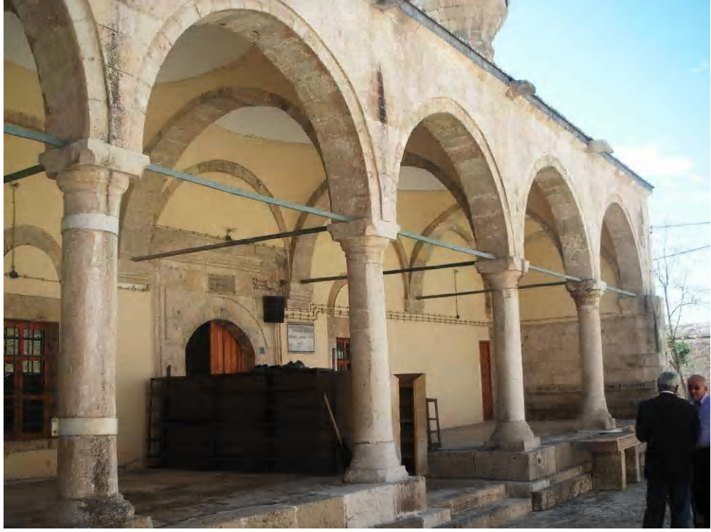
Fot.2.14. Köprülü Mehmet Paşa Camisi Son Cemaat Mahalli
