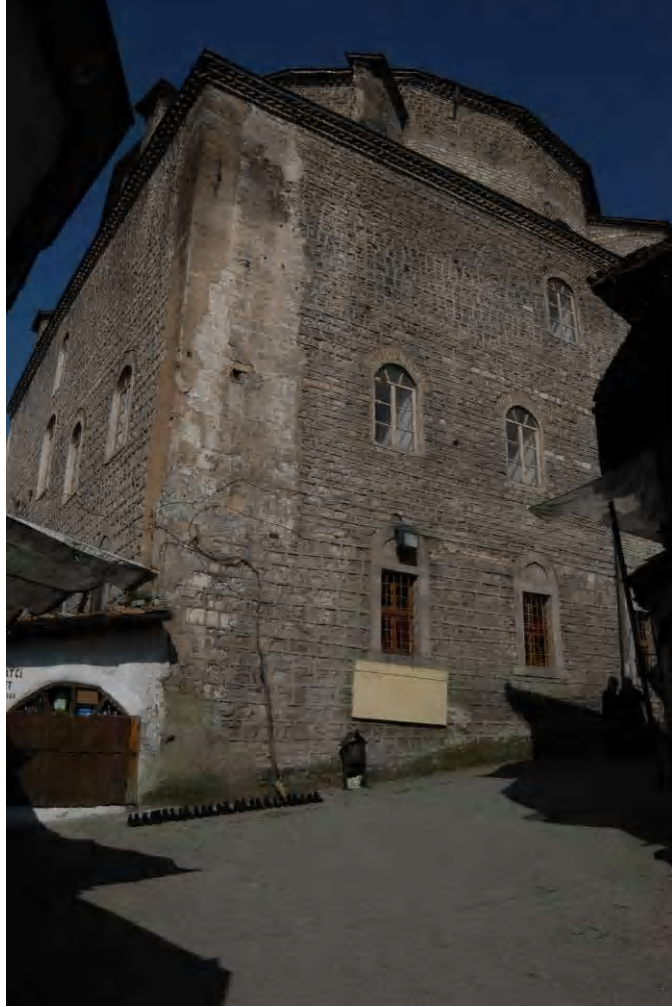
Fot.2.82. Safranbolu Köprülü Mehmet Paşa Camisi Güneydoğu Cephesi
