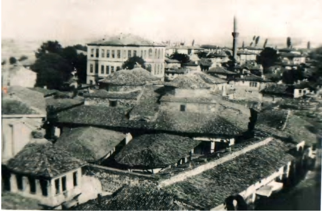
Fot.2.134. Vezirköprü Bedesten ve Arastası (Nejdet İğci Arşivi'nden)
