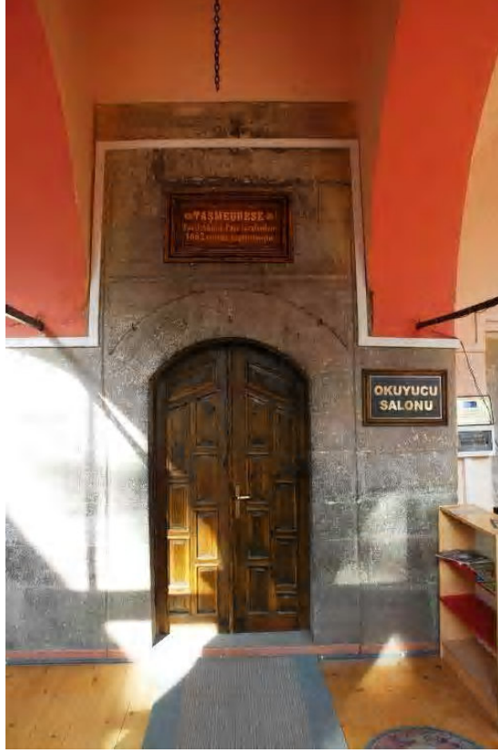
Fot.2.163. Dershane Hücresi Giriş Kapısı
