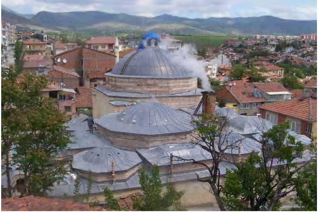
Fot.2.197. Merzifon Paşa Hamamı Üst Örtü Elemanları
