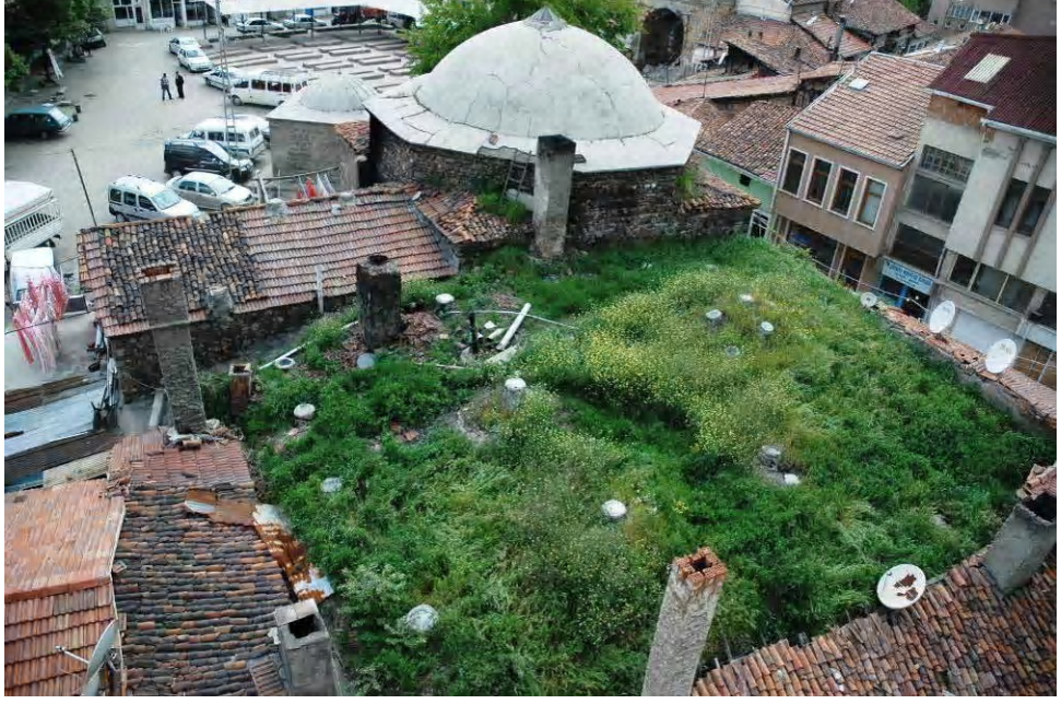
Fot.2.332. Gümüşhacıköy Yeni Hamam Üst Örtü Elemanları
