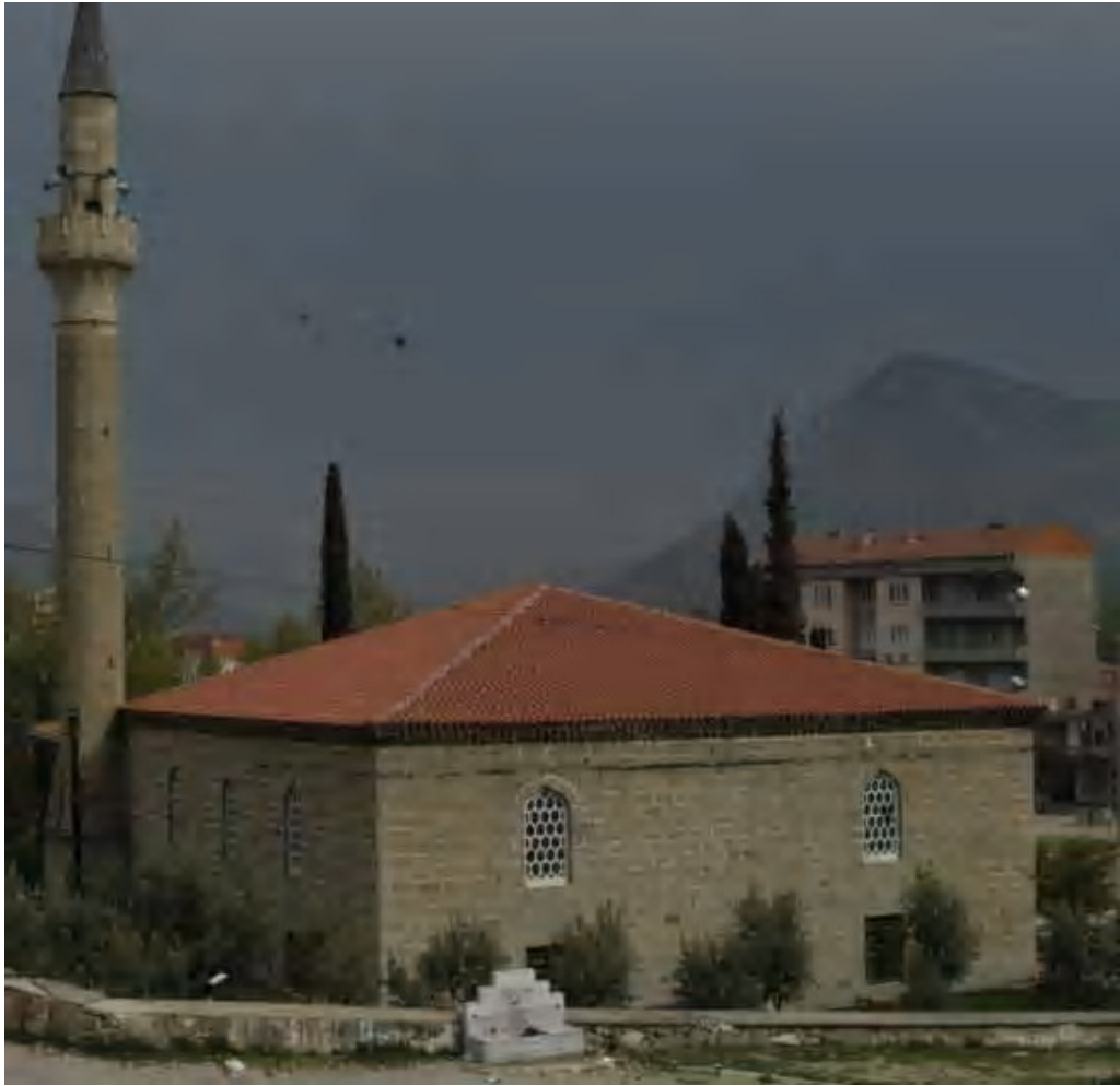
Fot.2.66. Vezirhan Köprülü Mehmet Paşa Camisi
