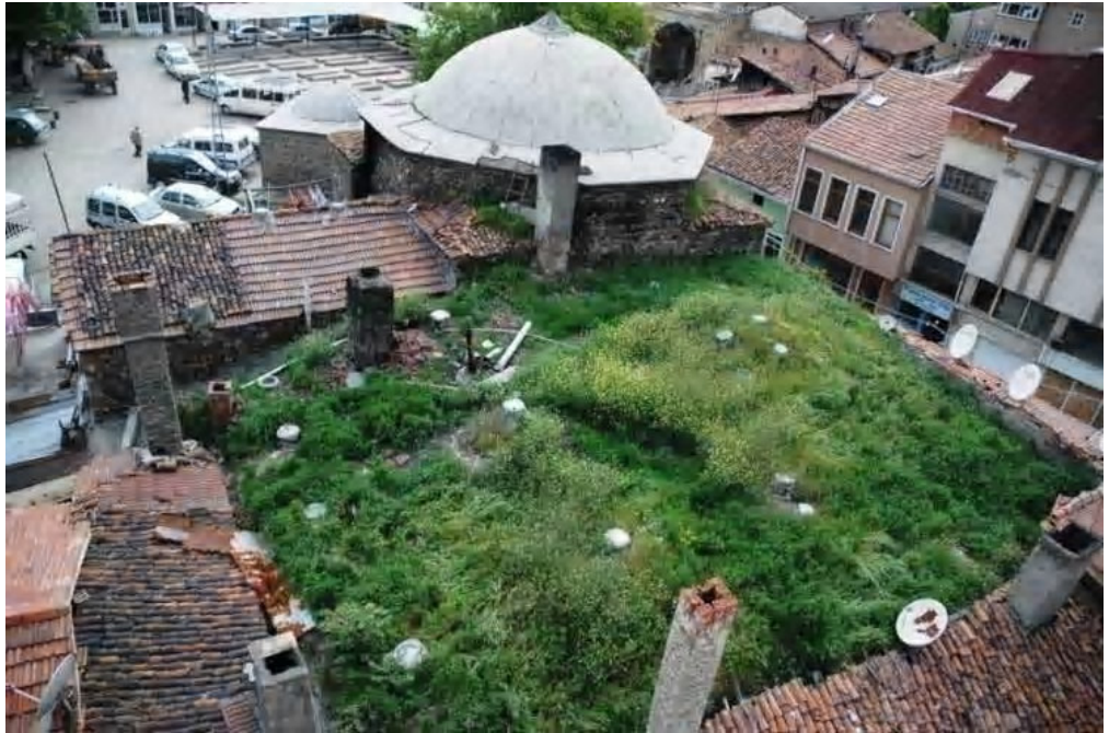
Fot.2.30. Gümüşhacıköy Köprülü Mehmet Paşa Hamamı Üst Örtü Sistemi
