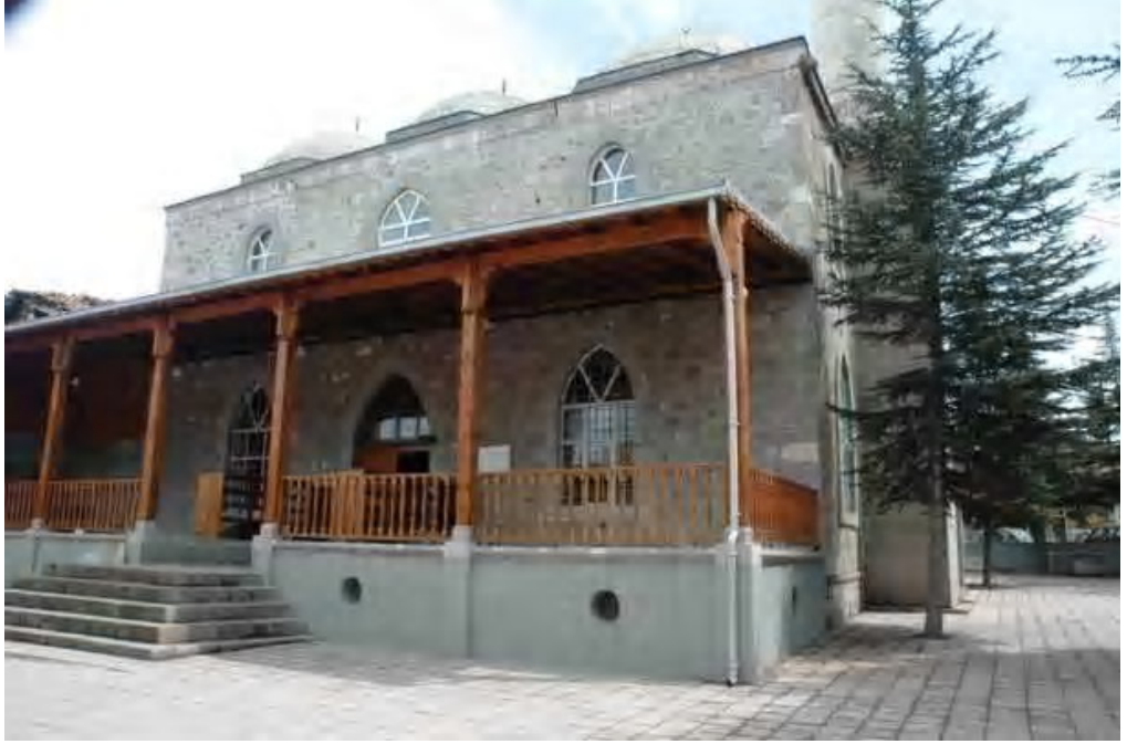
Fot.2.20. Gümüşhacıköy Köprülü Mehmet Paşa Camisi
