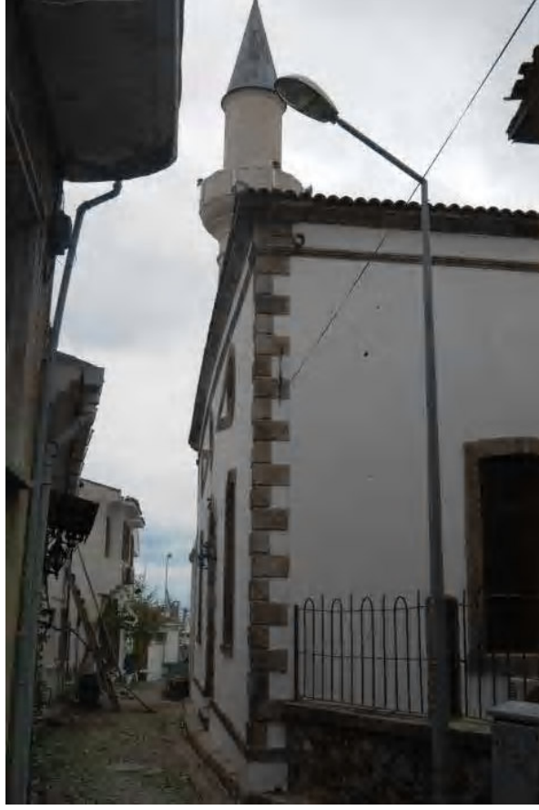
Fot.2.96. Bozcaada Köprülü Mehmet Paşa Camisi Kuzey ve Batı Cepheleri
