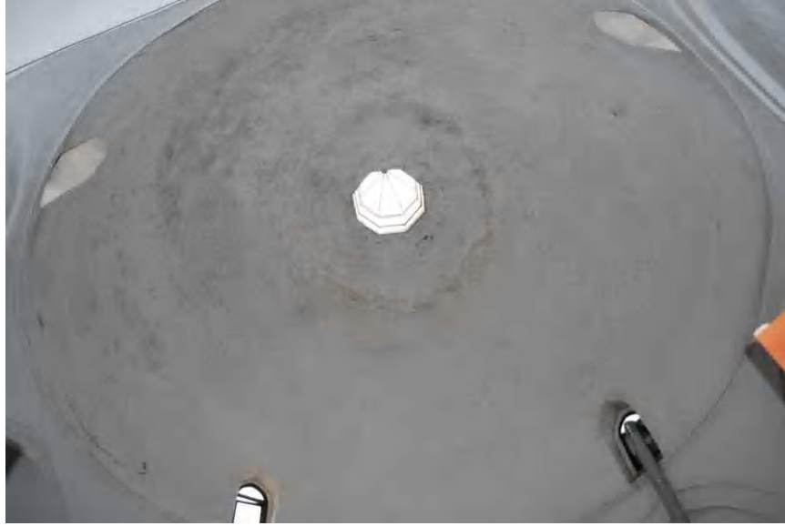
Fot.2.128. Vezirköprü Kale Hamamı Soyunmalık Kubbesi
