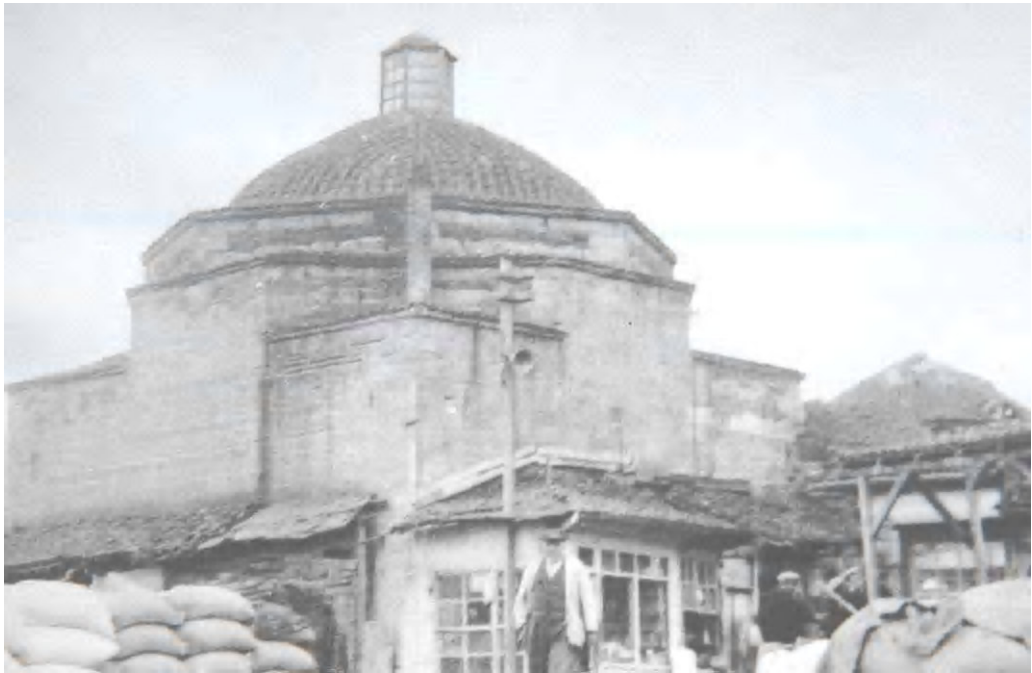
Fot.2.195. Merzifon Paşa Hamamı (V.G.M.A.)
