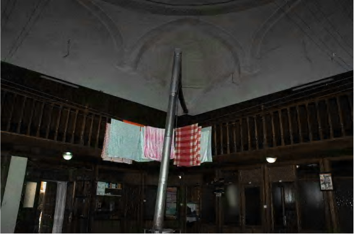
Fot.2.199. Merzifon Paşa Hamamı Soyunmalık Bölümü
