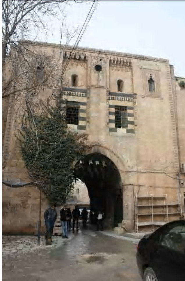
Fot.2.265. Halep Vezir Hanı Avlu Batı Cephesi
