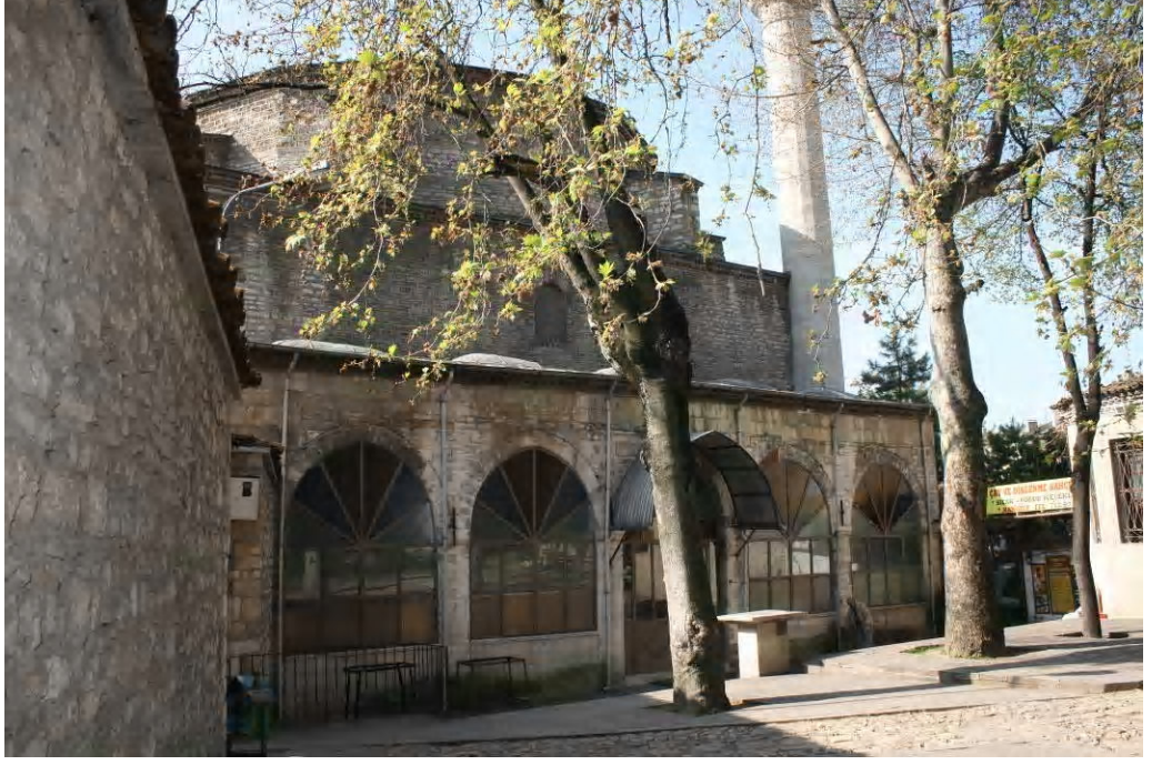
Fot.2.83. Safranbolu Köprülü Mehmet Paşa Camisi Kuzey Cephe
