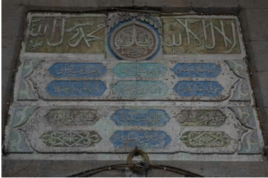
Fot.2.221. İncesu Kara Mustafa Paşa Camisi İnşa ve Onarım Kitabesi
