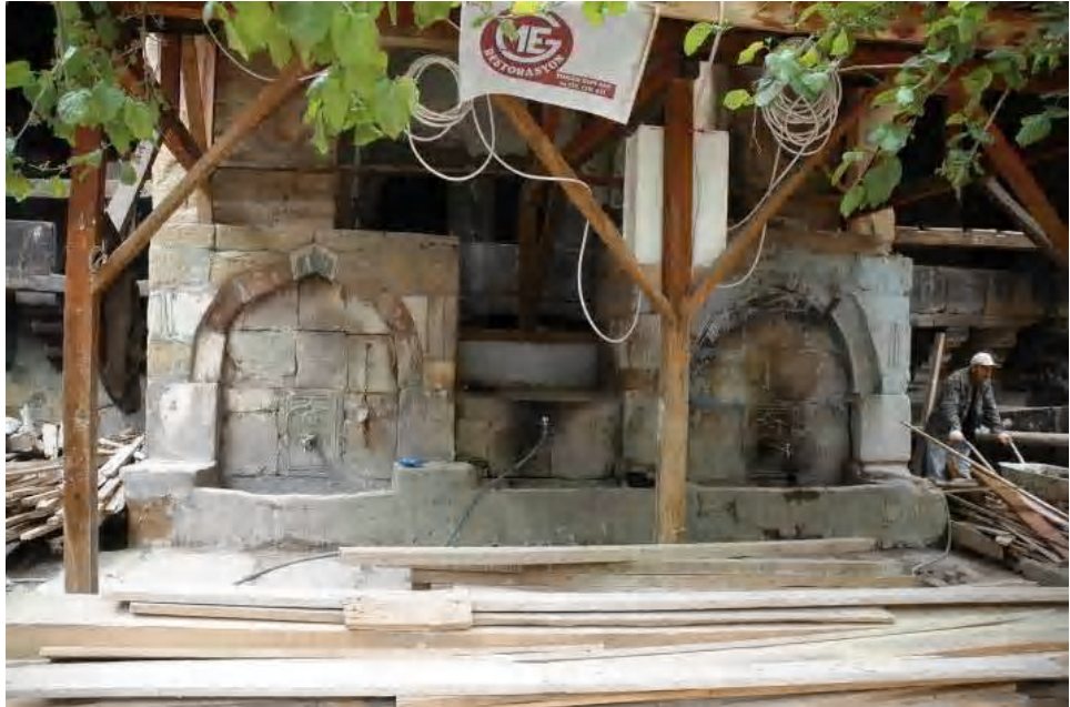
Fot.2.191. Merzifon Taşhan Avlusunda Bulunan Çeşmeler
