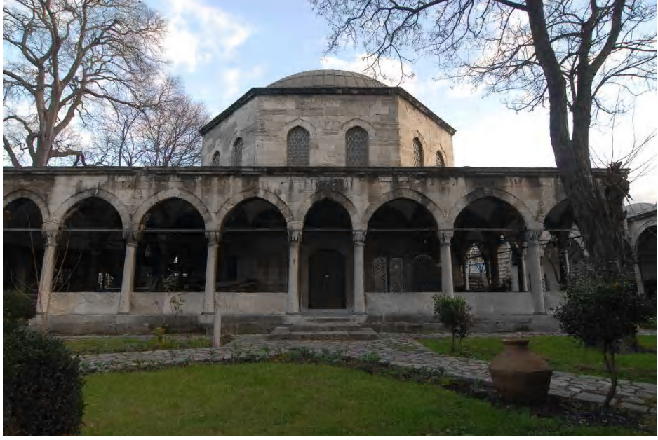
Fot.2.300. İstanbul Amcazade Hüseyin Paşa Külliyesi Dershane Mescit Binası (Mahir Polat Arşivi'nden)
