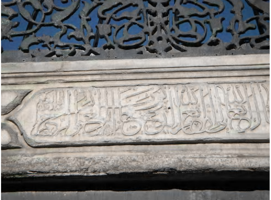
Fot.2.112. Avluya Bakan Cephe Üzerinde Yer Alan Arapça Kitabe
