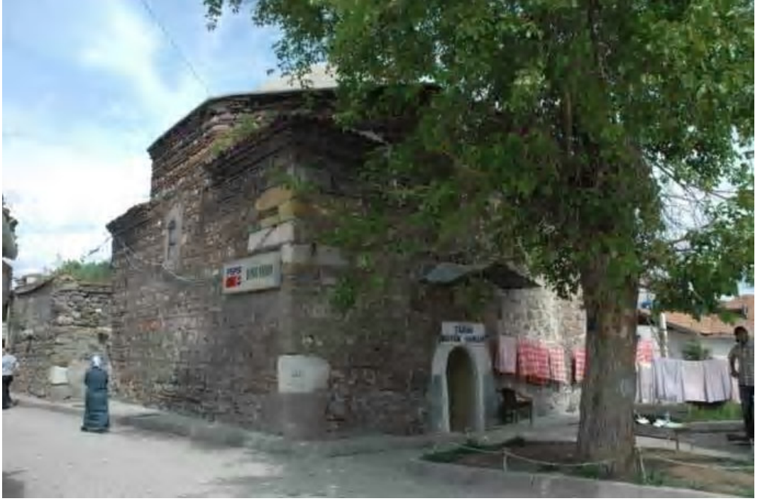
Fot.2.29. Gümüşhacıköy Köprülü Mehmet Paşa Hamamı
