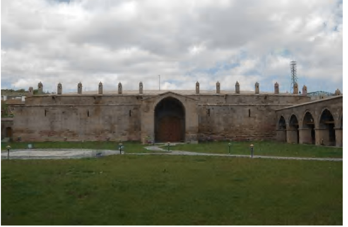
Fot.2.239. İncesu Kara Mustafa Paşa Kervansarayı Kapalı Kısım Giriş Eyvanı
