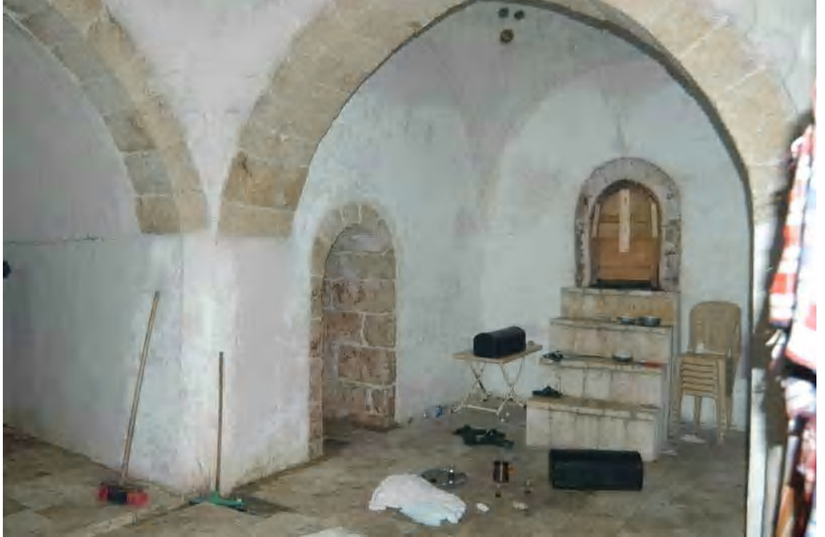
Fot.2.50. Cısr-i Şuğur Köprülü Mehmet Paşa Hamamı Sıcaklık Bölümü Batı eyvanı ve Güneydeki Halvet Hücresi
