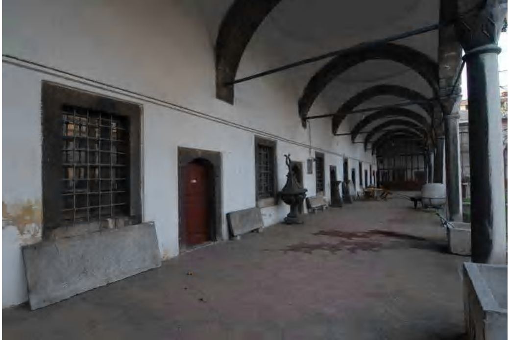
Fot.2.304. İstanbul Amcazade Hüseyin Paşa Külliyesi Öğrenci Hücreleri ile Medrese Revağı
