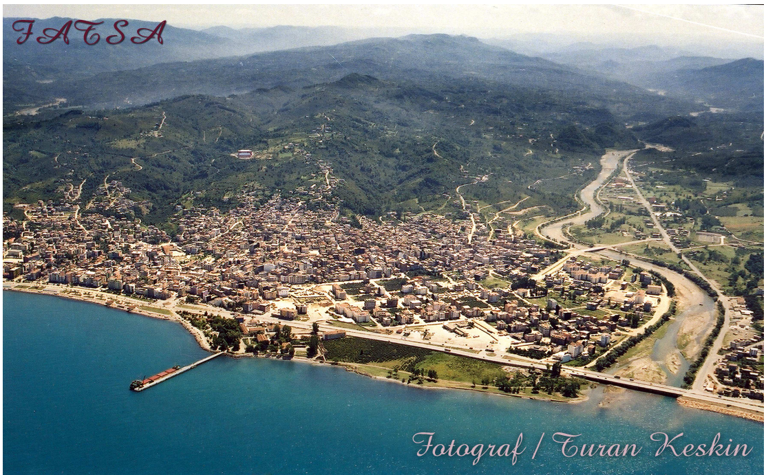
Foto1: Fatsa Şehir Merkezi ve Elekçi Deresi'nin Kuzeyden Görünümü.
