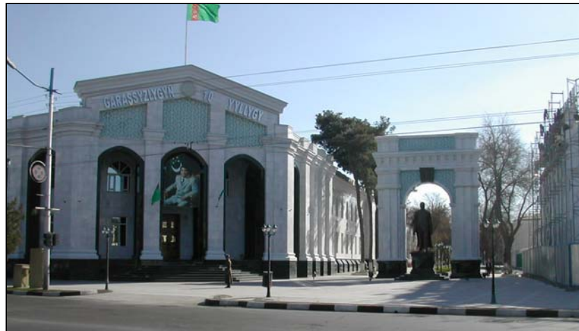
Resim 4.12. SSCB zamanlarındaki yönetim binası [Hoşgeldi arşivinden, 2006]
