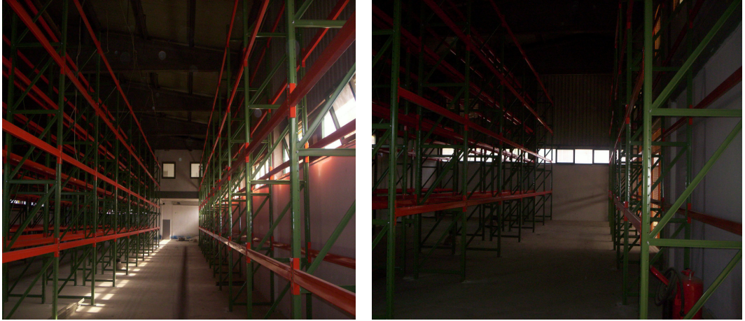
6.8. Depolardaki havalandırma pencereleri
