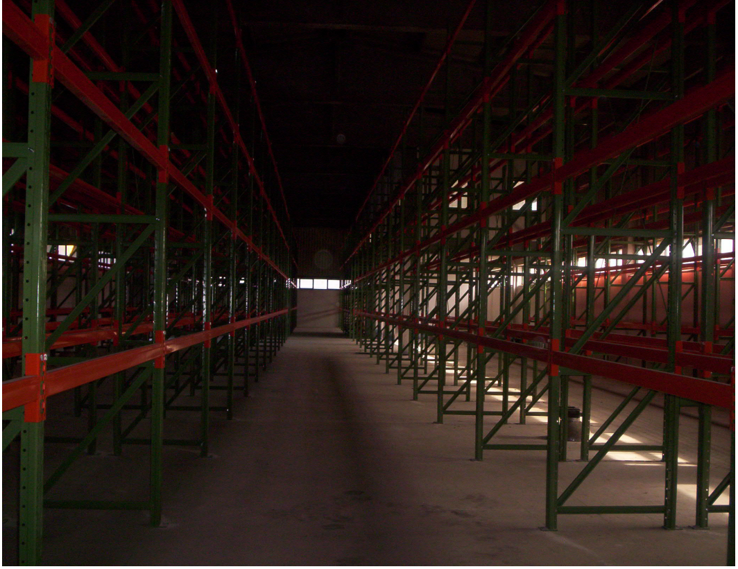
Şekil 6.12. Yeşil depo bitmiş hali 2
