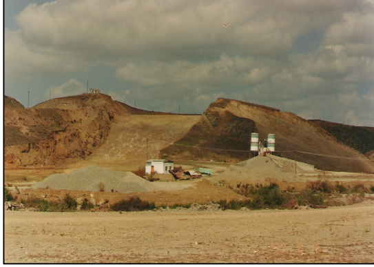
Foto 6 : Yapımı devam eden Kınık barajı
