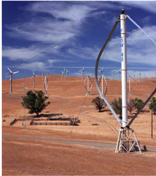
Şekil 4.1. Dikey eksenli bir rüzgar türbini [Şen, 2003]
