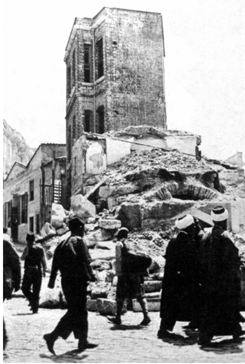
Şekil 4.20. Sultanhamam'da 1894 depreminde yıkılan Sıbyan Mektebi ile altındaki çeşme (İstanbulda Vuku Bulan Büyük Hareket-i Arz'a ait Albümler, Nr. 184/3, Atatürk Kitaplığı).
