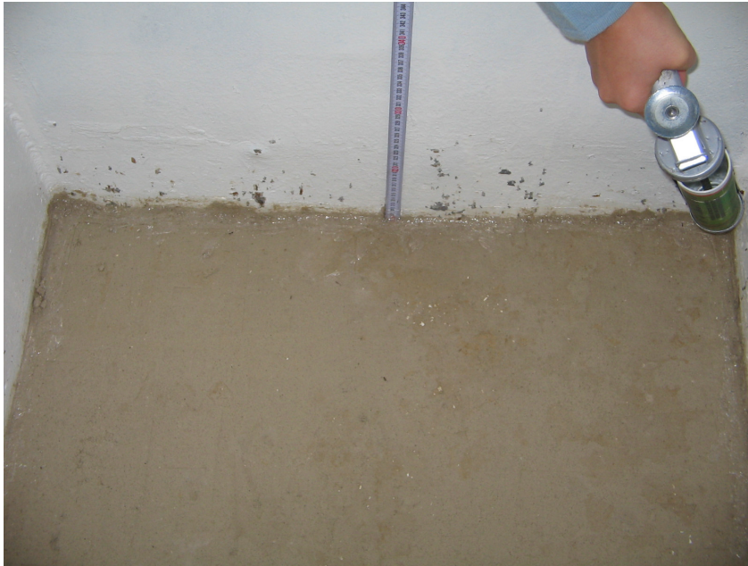
Şekil 5.17. Geçirimsizlik tabakasının kenarlarına silikon çekilmesi
