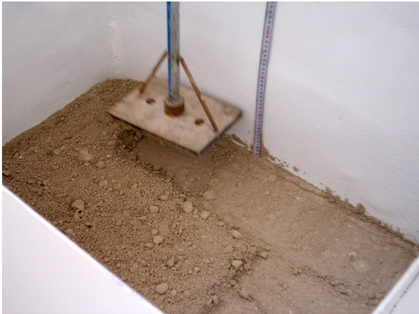
Şekil 5.14. Geçirimsizlik malzemesinin sıkıştırılması
