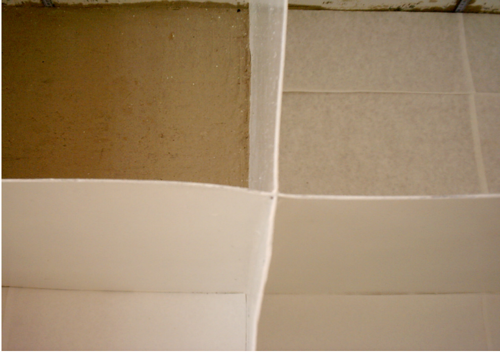
Şekil 5.15. Geçirimsizlik tabakasının sıkıştırılmış ve üzeri poroz kağıt kaplanmış hali
