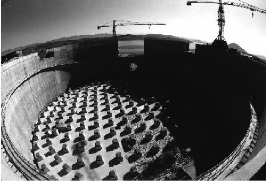
Şekil 2.17. Yunanistan’ın Revithoussa Adasındaki İzolatörlü LNG Deposu İnşaatı
