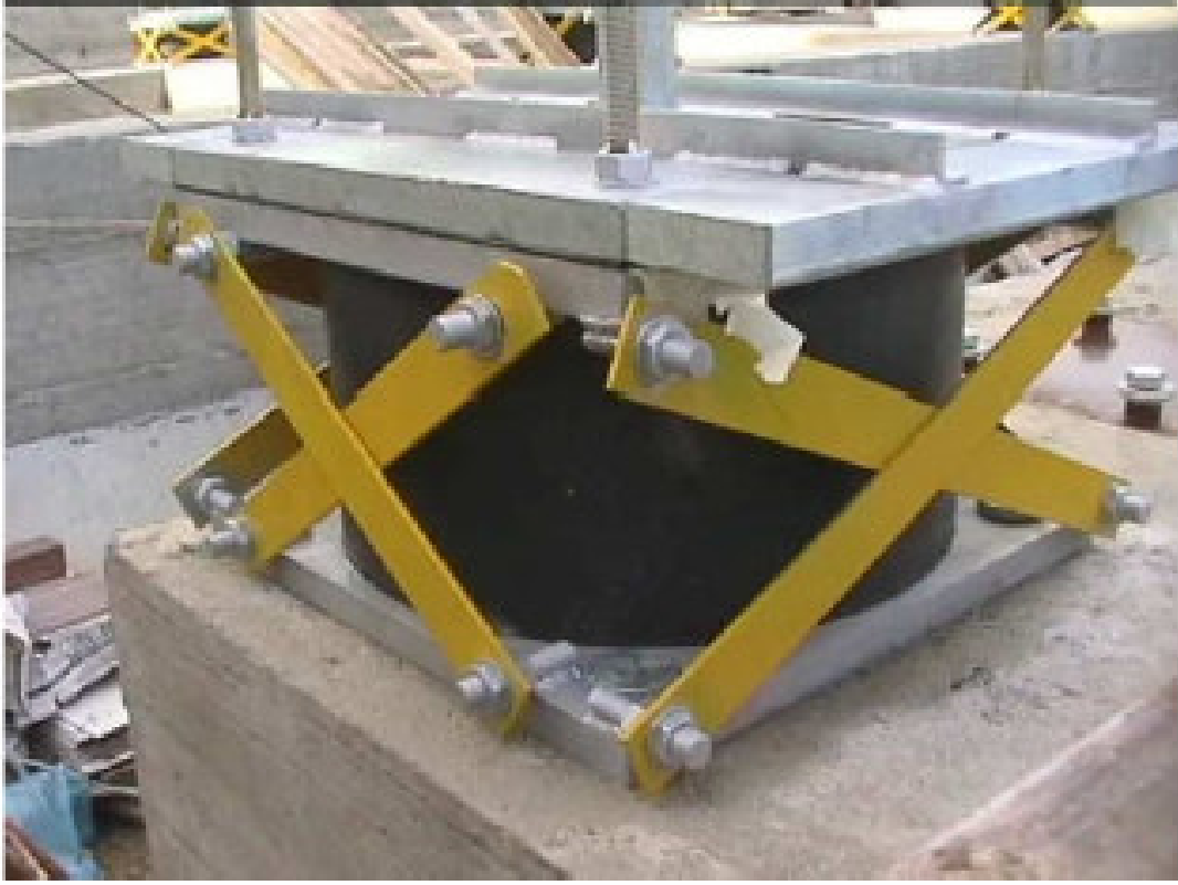
Şekil 2.19. İzolatörlü Temel İnşaatında Yakın Görünüş (Anonim, 2005c)
