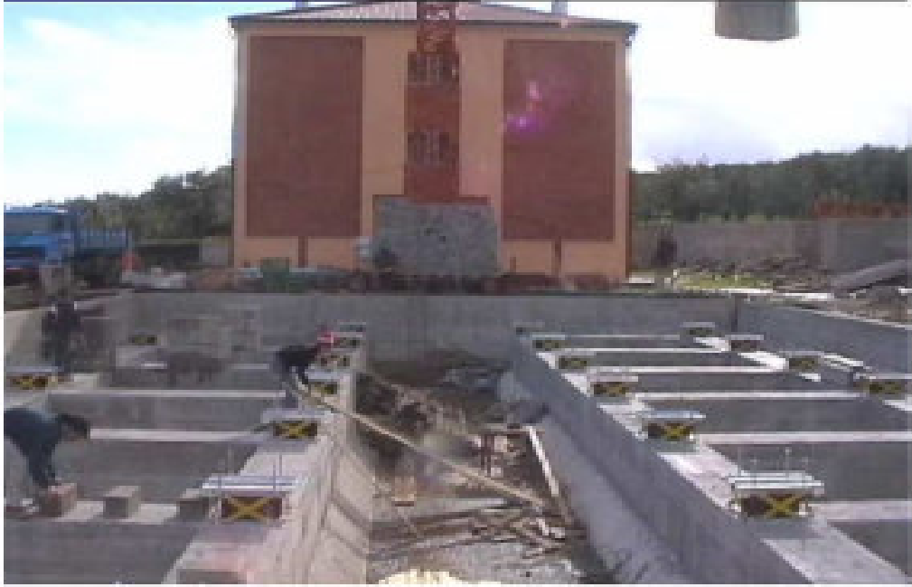
Şekil 2.18. İzolatörlü Temel İnşaatı (Anonim, 2005c)
