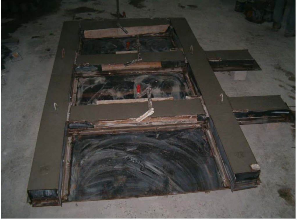
Resim 4.3 Deney elemanı betonunun dökümü
