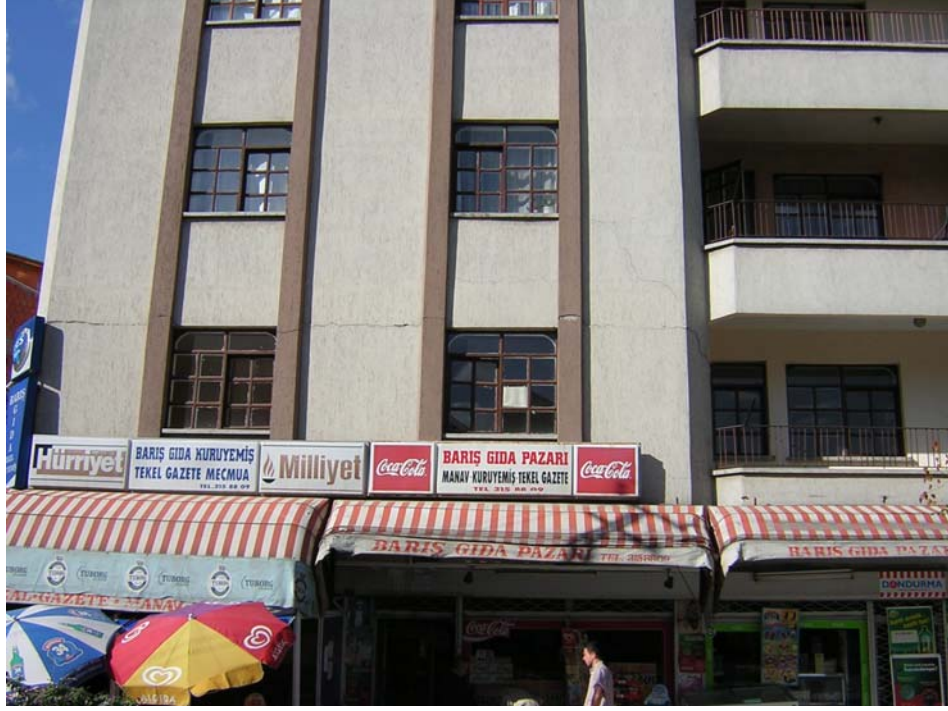
Resim 5.11. konsol çıkmalı betonarme binalardaki çatlaklar
