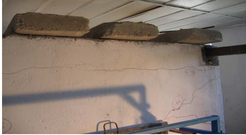
Şekil 5.23 2 nolu deney numunesinde +58 kN'da oluşan çatlaklar
