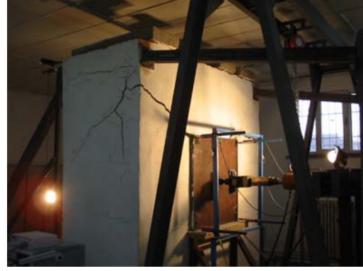
b) Ön duvarla sağ yan duvarın üst birleşiminde oluşan çatlaklar
