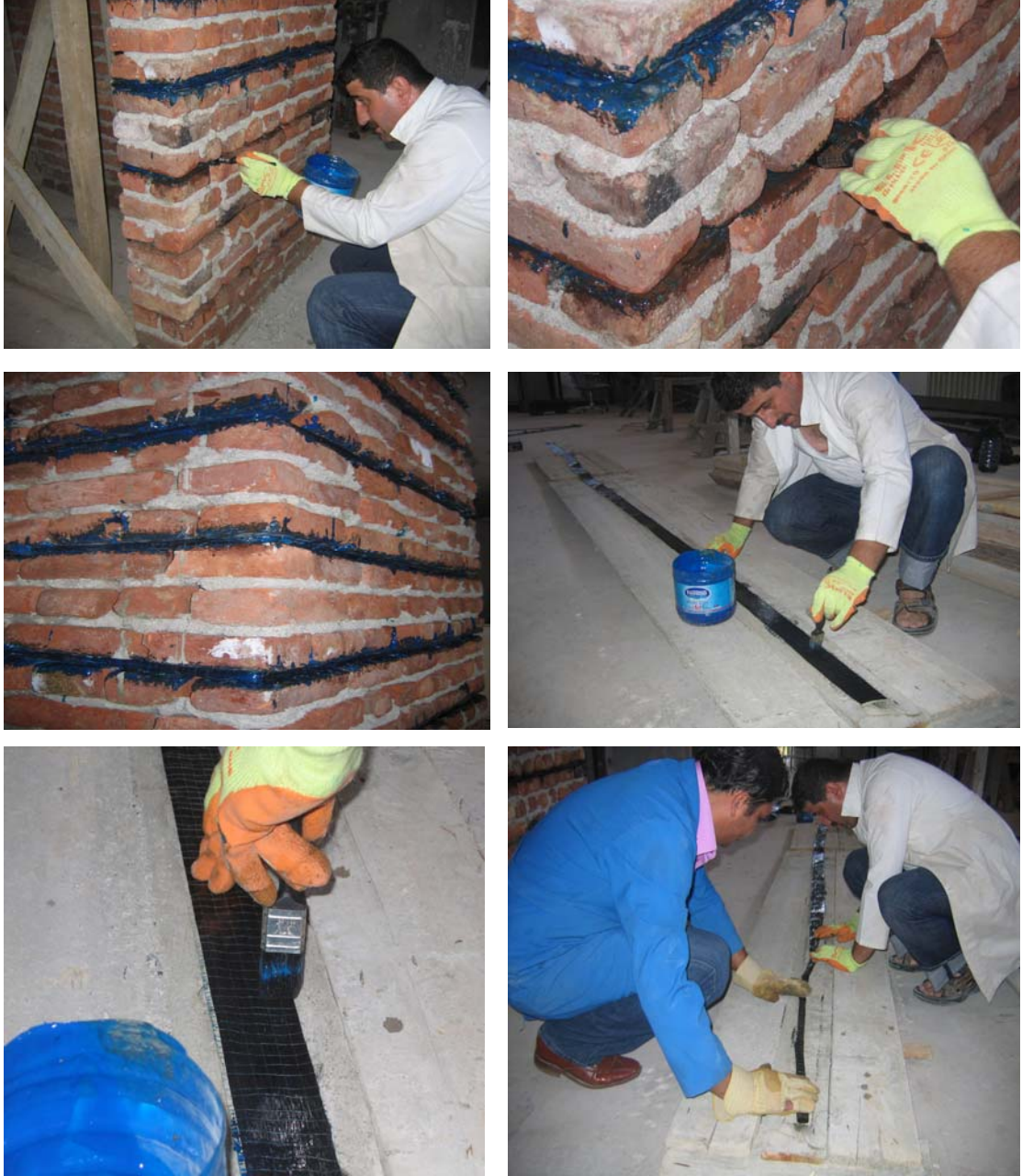
Şekil 3.11 Hazırlanan reçinenin duvara ve FRP üzerine uygulanması
