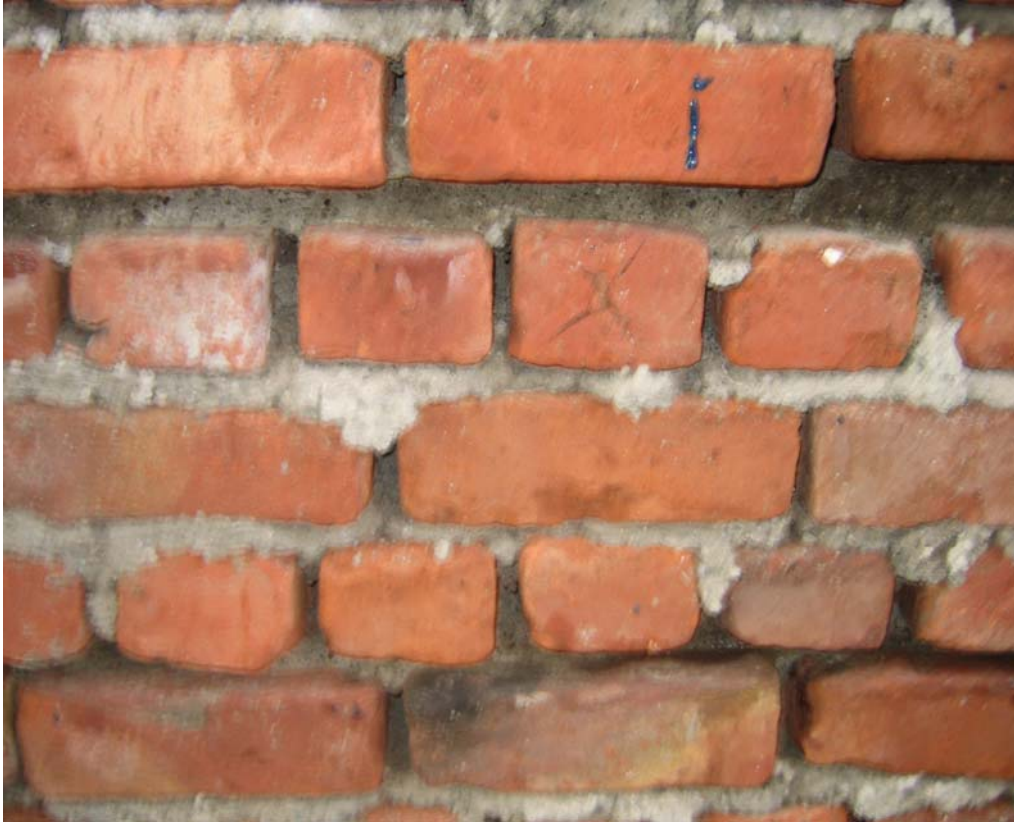
Şekil 3.5 Örülmüş tuğla duvarın görüntüsü
