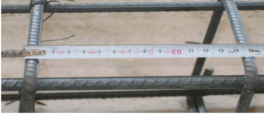
Şekil 3.3 Bağ kiriş donatı görüntüsü
