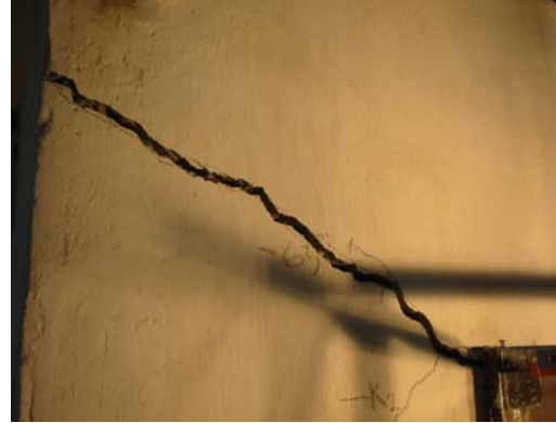
f) Yükleme levhasının sağ üst köşesinde oluşan çatlak
