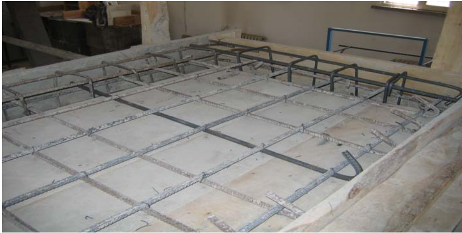
Şekil 3.4 Döşeme donatısının görüntüsü
