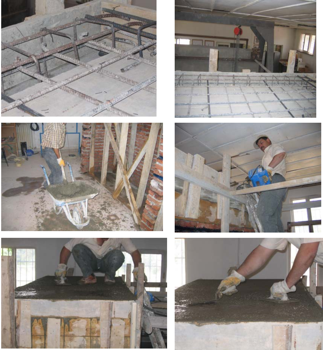
Şekil 3.8 Numuneye kalıp kurulması ve beton dökülmesi
