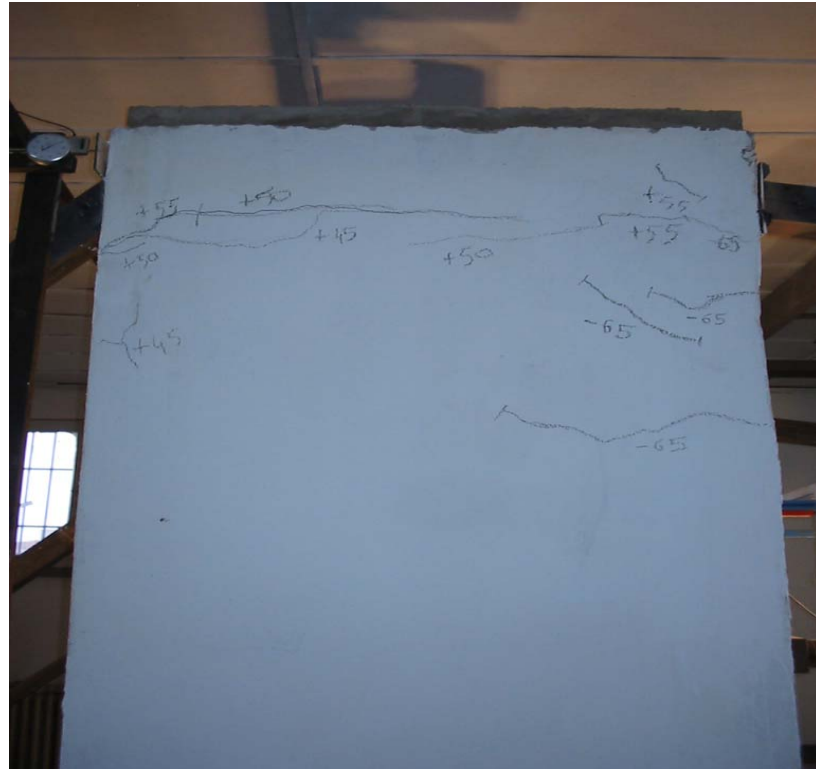
Şekil 5.5 1 nolu deneyde 6. çevrimde oluşan çatlaklar
