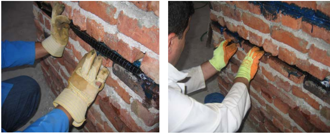
Şekil 3.12 Hazırlanan FRP’nin duvara uygulanması
