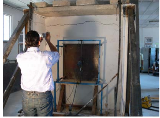
d) Arka duvarın orta kısmındaki çatlaklar
